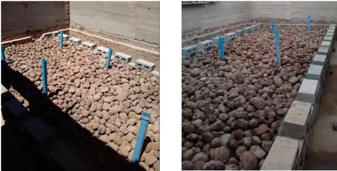
Ilustración 7. Lecho empacado en construcción.[15]
