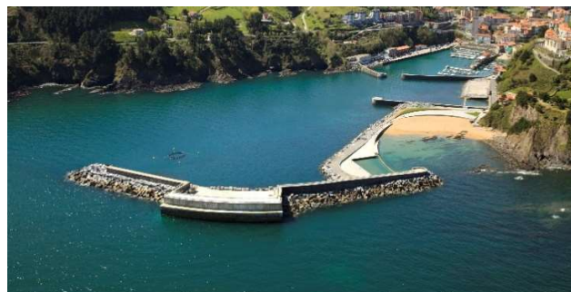
Fig. 1. Planta de Energía Undimotriz de Mutriku en España.
