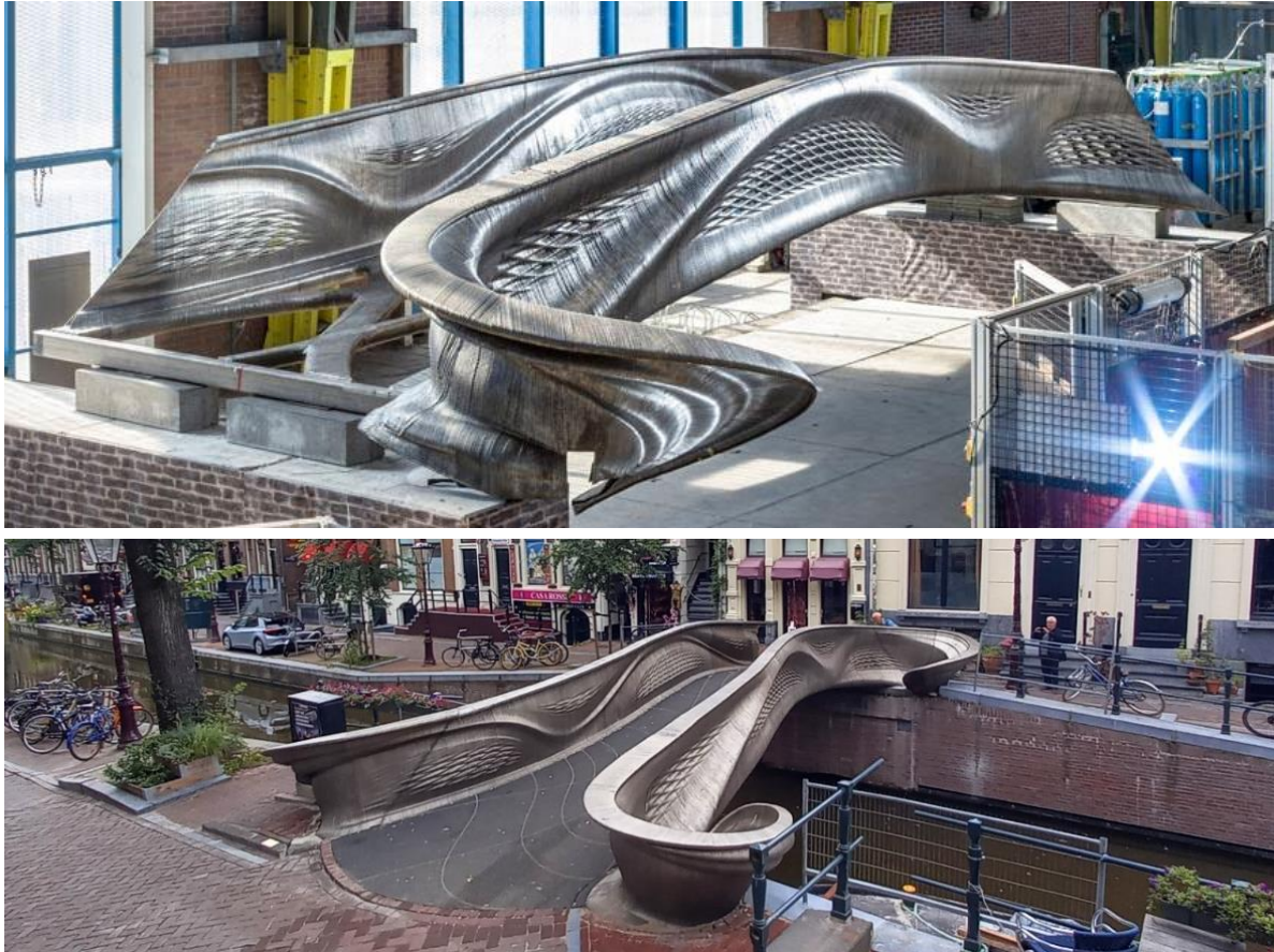
Figura 2.13: Puente de uso público fabricado por WAAM de acero instalado en el centro de Amsterdam. Imagen reimprimida con permiso de MX3D [28].
