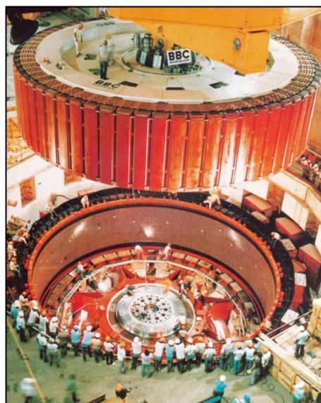
**Figura 9:** Rotor de Polos Salientes (Hidroalternador de la central de Itaipú) [9].
