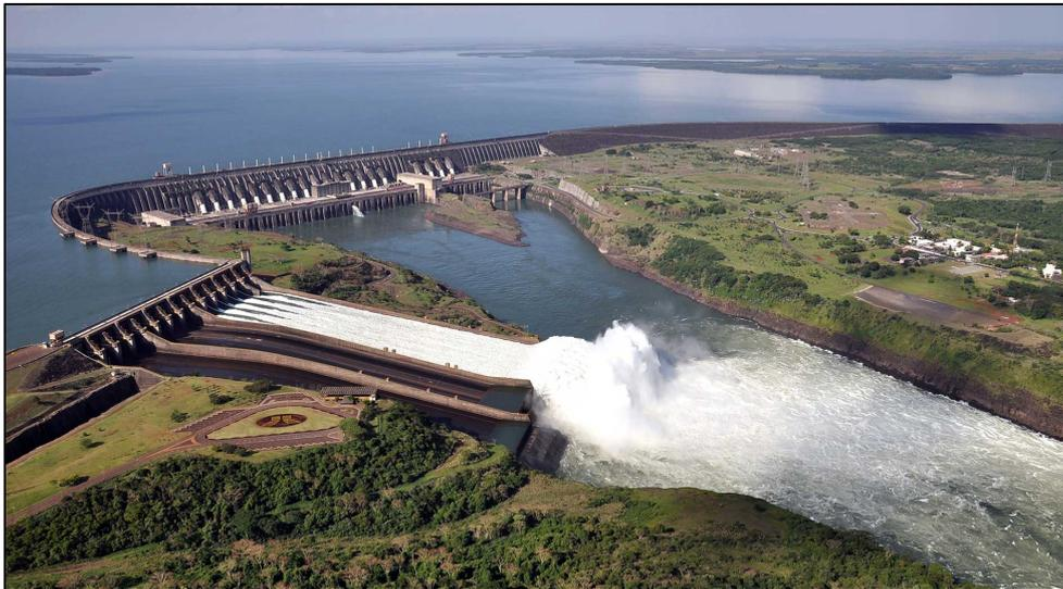
**Figura 6:** Presa de Itaipu - Río Paraná - Potencia Instalada de 14 GW - 20 Generadores de 18kV [10].
