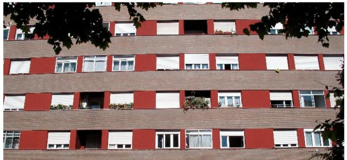
**Figura 128.** Desorden en el despiece y combinación de color de la carpintería y persianas en edificio del barrio de Otxarkoaga (A) y tratamiento unificado de color en una fachada del barrio de El Pilar (B). Fuente: elaboración propia
