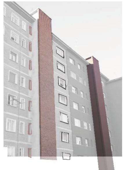
La mayoría de las viviendas se realizaron originalmente mediante fábrica de ladrillo y ha habido casos en los que las **rehabilitaciones de la envolvente de aislamiento térmico y acústico han generado una notable discordancia** en contraposición con el proyecto original. De hecho, se observan varios bloques de viviendas con rehabilitación energética en sus fachadas (SATE) pero sin criterio uniforme en cuanto a material y tratamiento se refiere.
