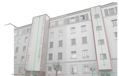
La existencia de cierres acristalados en los balcones de viviendas, generan una **nueva imagen de fachada que no respeta la volumetría ni los elementos originales del edificio**, creando superficies totalmente alteradas, sin retranqueos ni contrastes de luces y sombras. Esto unido al denso y arbitrario despiece y particiones, generan un gran impacto visual presente en gran parte de las fachadas principales de los edificios de viviendas del barrio.
