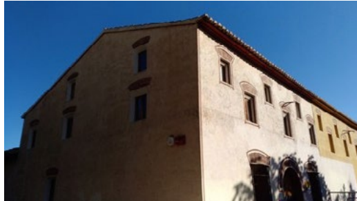
Fig. 11. Imagen del estado actual del elemento 11. Molí Sant Miquel, 2019
