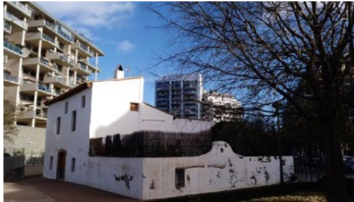
Fig. 7. Imagen del estado actual del elemento 7. l'Alqueria Puchades, 2019
