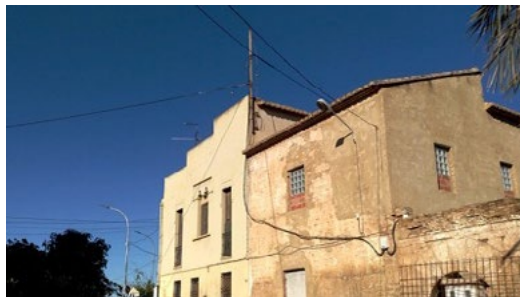
Fig. 13. Imagen del estado actual del elemento 13. l'Alqueria Fonda, 2019
