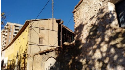
Fig. 10. Imagen del estado actual del elemento 10. l'Alqueria Llorenç, 2019
