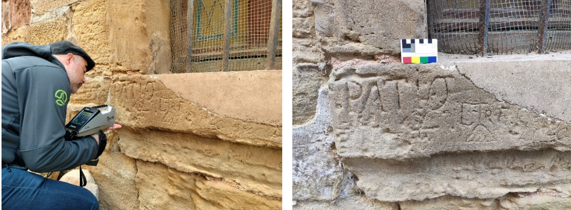
Fig. 25.- Toma de datos químicos (izquierda) e imagen de detalle del estado del grafito (derecha).
