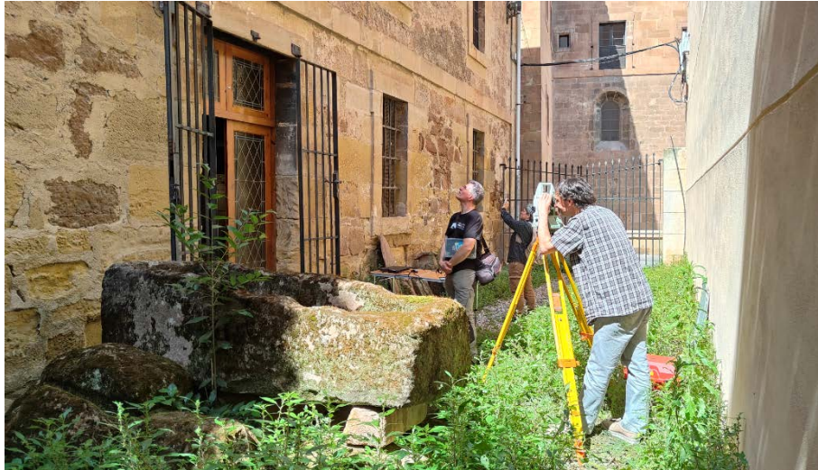
Fig. 22.- Obtención de coordenadas de los puntos de apoyo situados en la fachada del patio exterior mediante una estación total topográfica.
