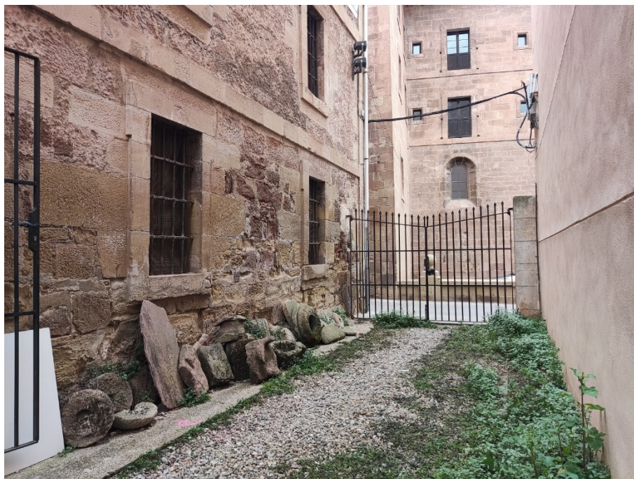
Fig. 2.- Patio del edificio, sobre cuyos muros se encuentran varios grafitos.
