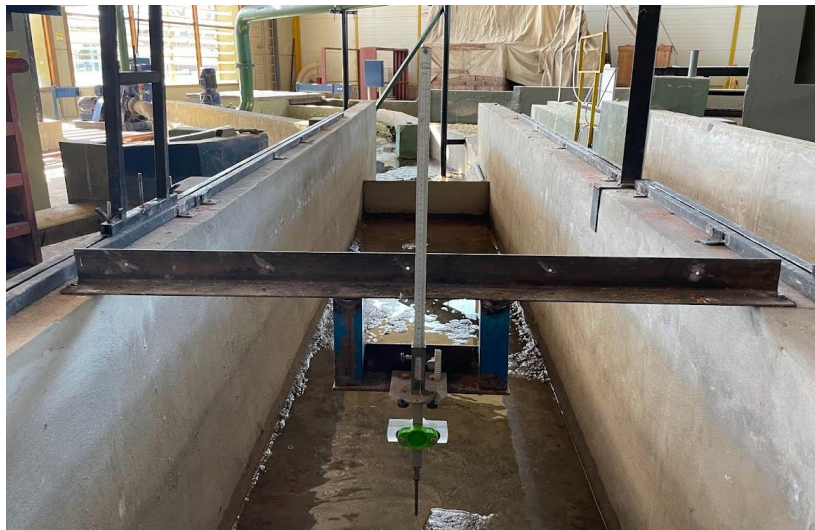
Figura 23: Soporte estructural para fijar la turbina.
