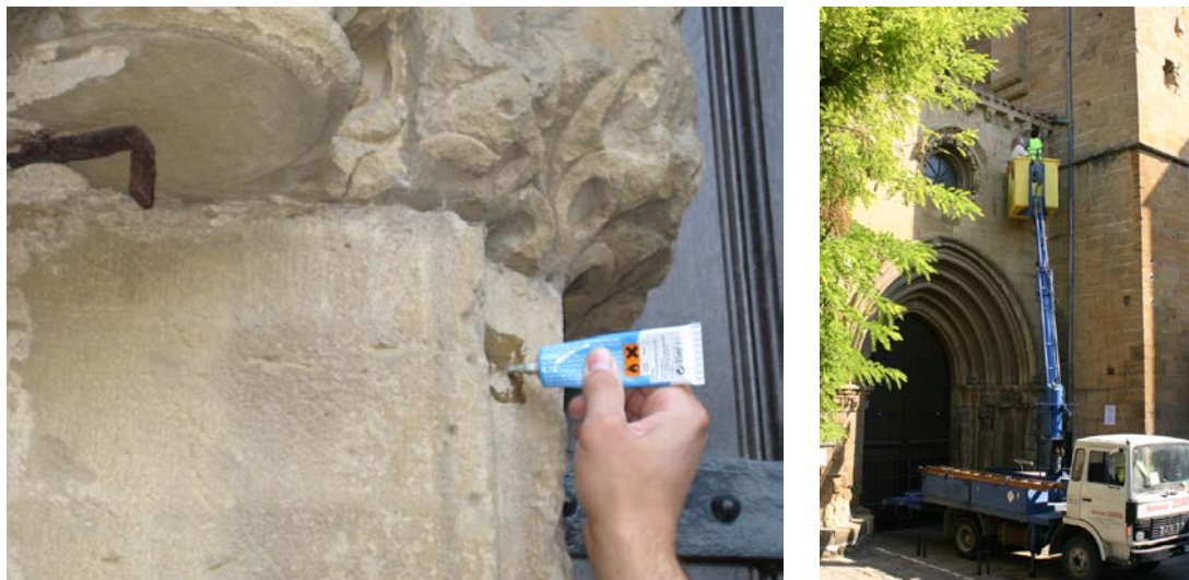
Figura 4. Preparación de la superficie (izquierda) y colocación de las señales utilizando un camión grúa para acceder a toda su extensión.
