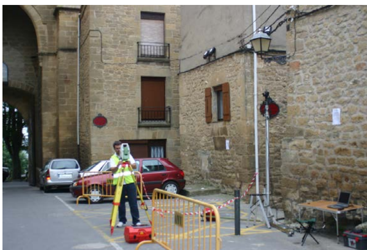
Figura 6. Toma de datos con estación total topográfica.
