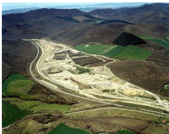
FIGURA 5.11. VERTEDERO DE GARDELEGI
