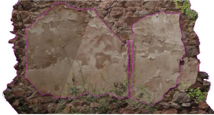
*Imagen 7.19. Detalle de la textura del modelo del paño Norte del muro "J" en Image Master*
