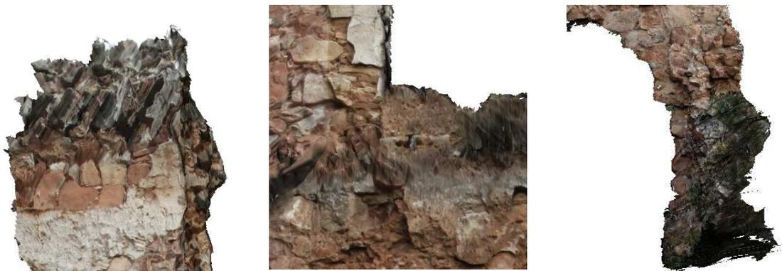
*Imagen 7.21. Detalles de las zonas de mayor error en el modelo del paño Sur del muro "J"*
