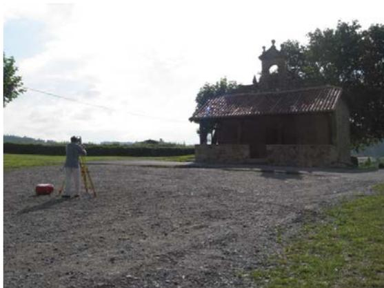
Fotografía 3. Toma de datos topográficos
