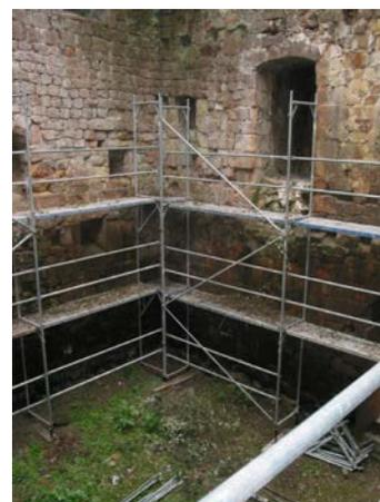
*Fotografías 6 y 7. Limpieza de maleza, colocación de dianas y estructura*
