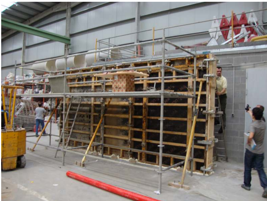
4.2 Irudia: Enkofratu eta junta zigilatuen ikuspegia.
