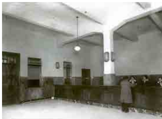
Ignacio de Cárdenas. 1926-27. Interior del edificio de Telefónica.
