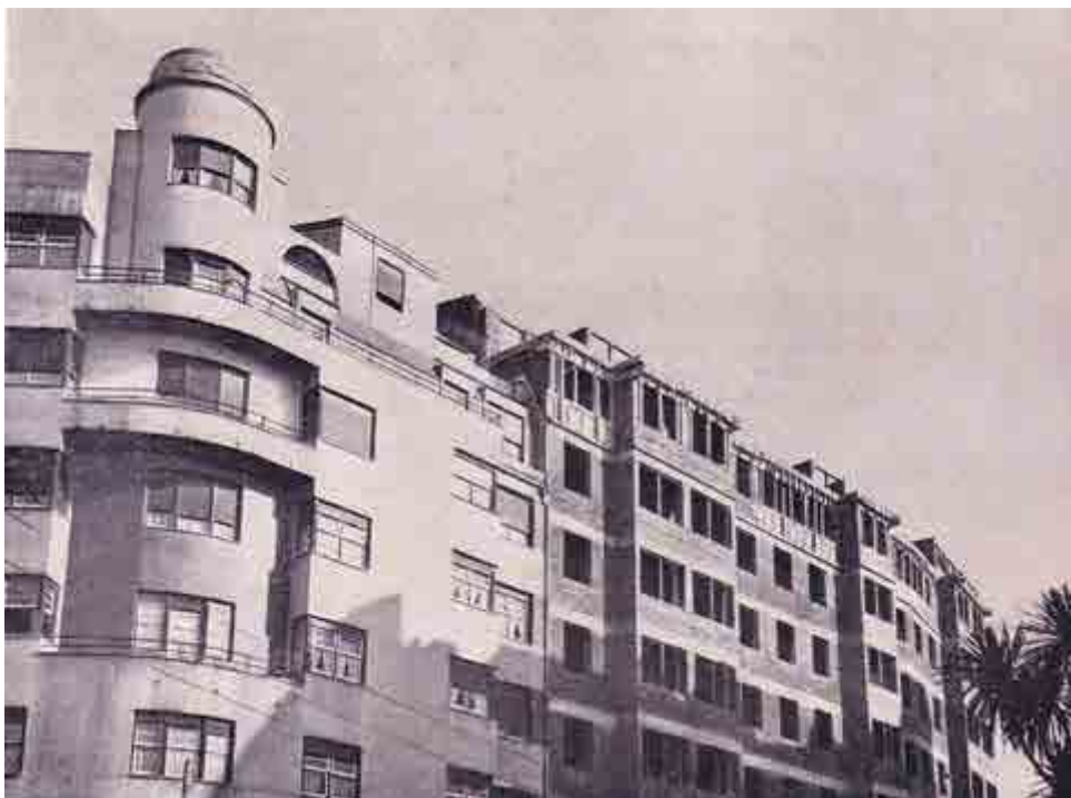
Pedro Guimón. 1931-32. Casa de vecindad en Gregorio de la Revilla 35. Estanislao Seguro. 1934-35. Casa de vecindad en construcción entre las calles de Gregorio de la Revilla 37, 39 y 41, General Eguía 2 y 4.
