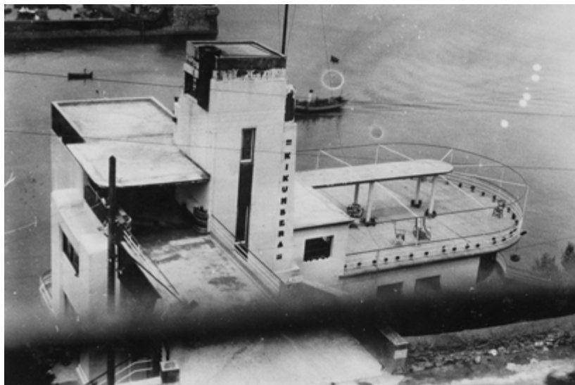
Fernando Arzadun. 1930. Casa Kikumbera en Bermeo.
