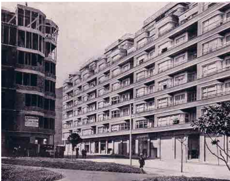
Pedro Guimón. 1934-35. Casa de vecindad en construcción en Alda. Urquijo 61. Tomás Bilbao. 1933-35. Casas de vecindad en Alda. Urquijo 58, 60, 62 y 64.
