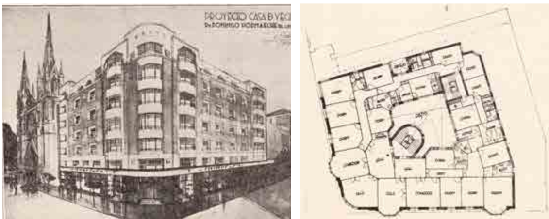
Manuel I. Galíndez. 1931-33. Edificio para Siemens y Domingo Hormaeche.
