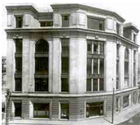
Ignacio de Cárdenas. 1926-27. Central automática de Telefónica.
