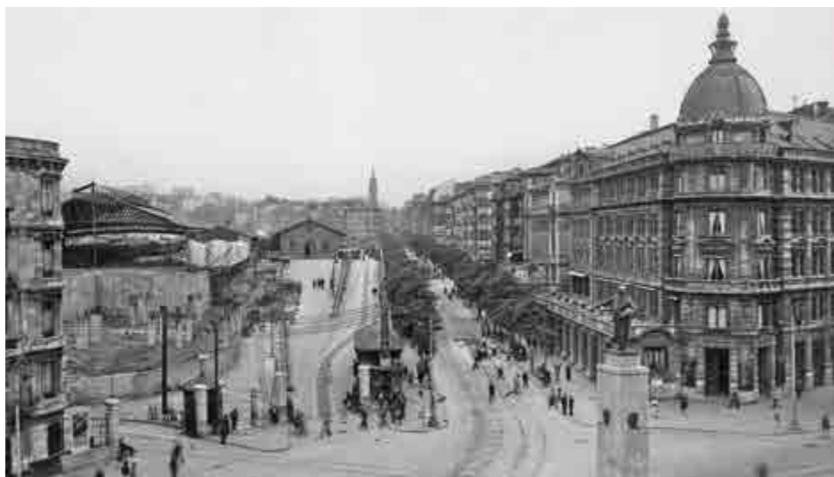
Obras de construcción de la Estación de Abando.
