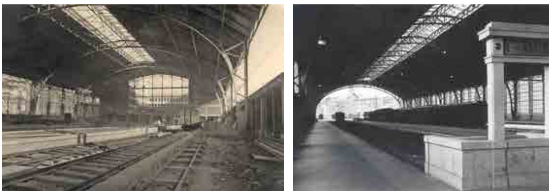
Marquesina y andenes de la Estación de Abando. 1941-48.
