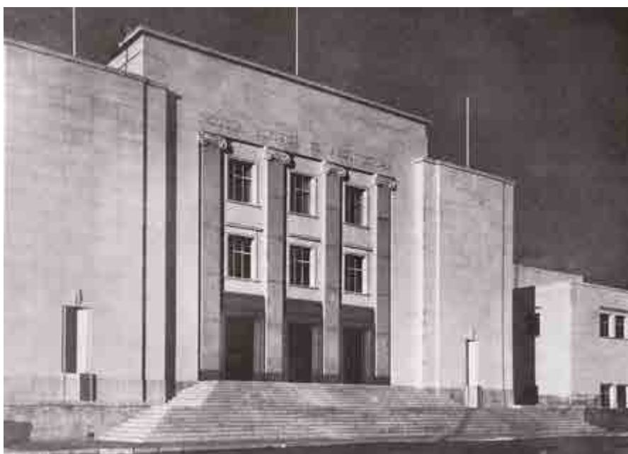
Pascual Bravo. 1941-43. Escuela Superior de Arquitectura de Madrid.
