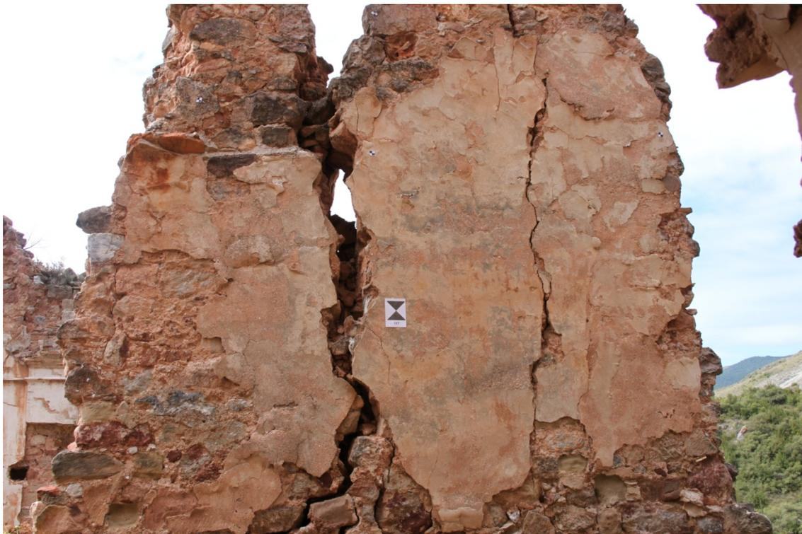
18 Separación de un muro en dos partes debido a la degradación
