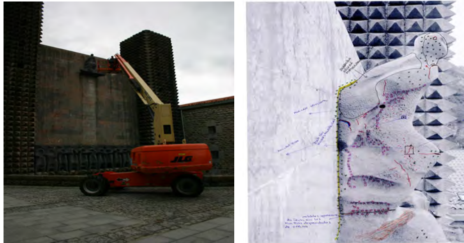
Fig. 3.2.- Análisis del estado de conservación de la imagería exterior del Santuario de Arantzazu, Gipuzkoa (LDGP, 2009). La imagen de la derecha muestra las patologías detectadas en una figura del exterior del Santuario; sin embargo, su explotación comercial fuera del encargo para el que fue concebida debe tener en cuenta los derechos del autor de la obra (Jorge Oteiza) ya que al tratarse de una obra reciente sus derechos aún no han expirado (Minerva, 2008: 40), del propietario de la obra (la comunidad religiosa del Santuario), del fotógrafo que obtuvo la imagen, de la restauradora que realizó el análisis y lo plasmó sobre la fotografía, etc.
