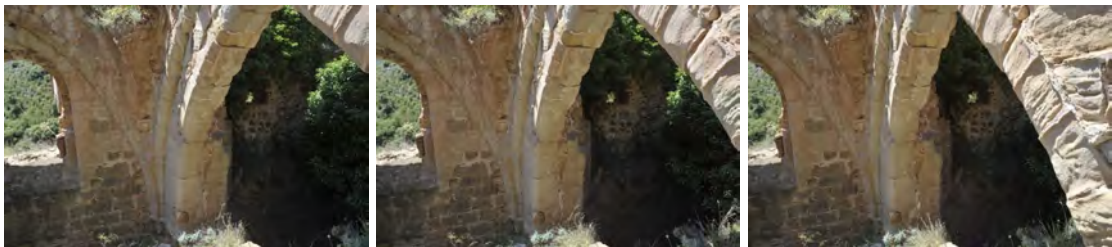
Fig. 9.19.- Conjunto de tres fotografías con puntos de vista ligeramente desplazados a lo largo de una línea (tripleta) que se deben procesar de forma conjunta para obtener resultados métricos.
