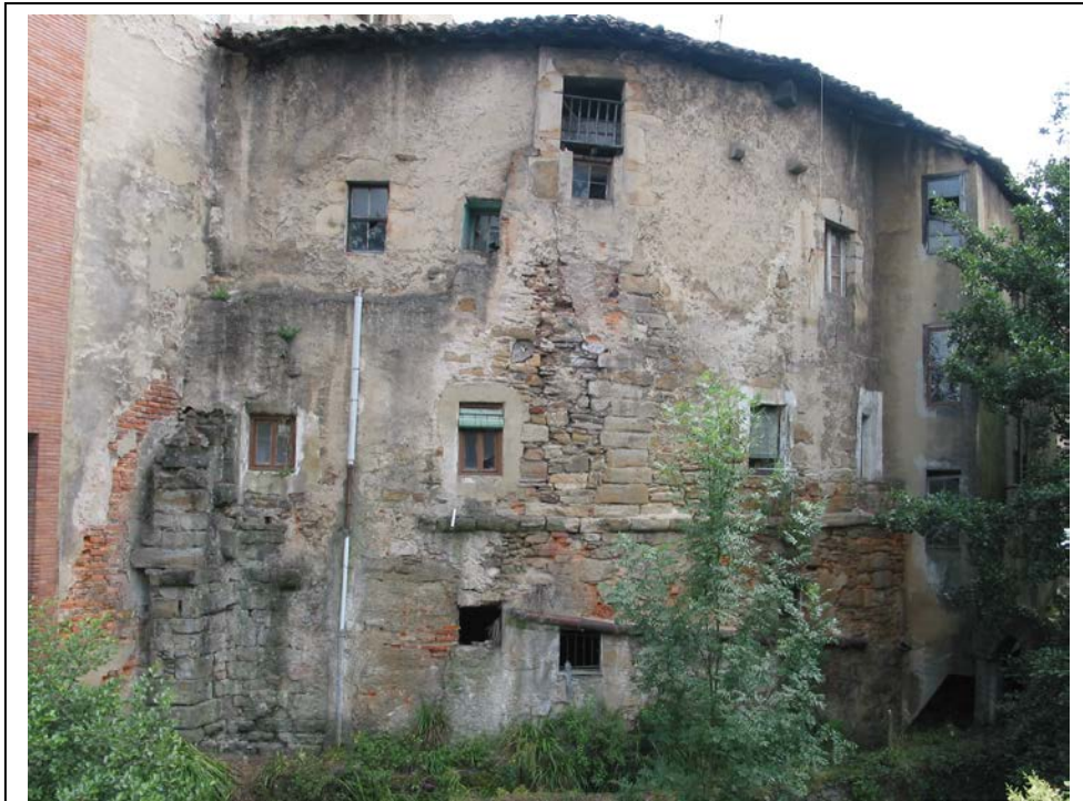
Figura 1.- Dificultades a la hora de extraer texturas de fotografía real: zonas ocultas por vegetación, presencia de canalizaciones, cables, etc. (Torre de Láriz, Durango, Bizkaia).
