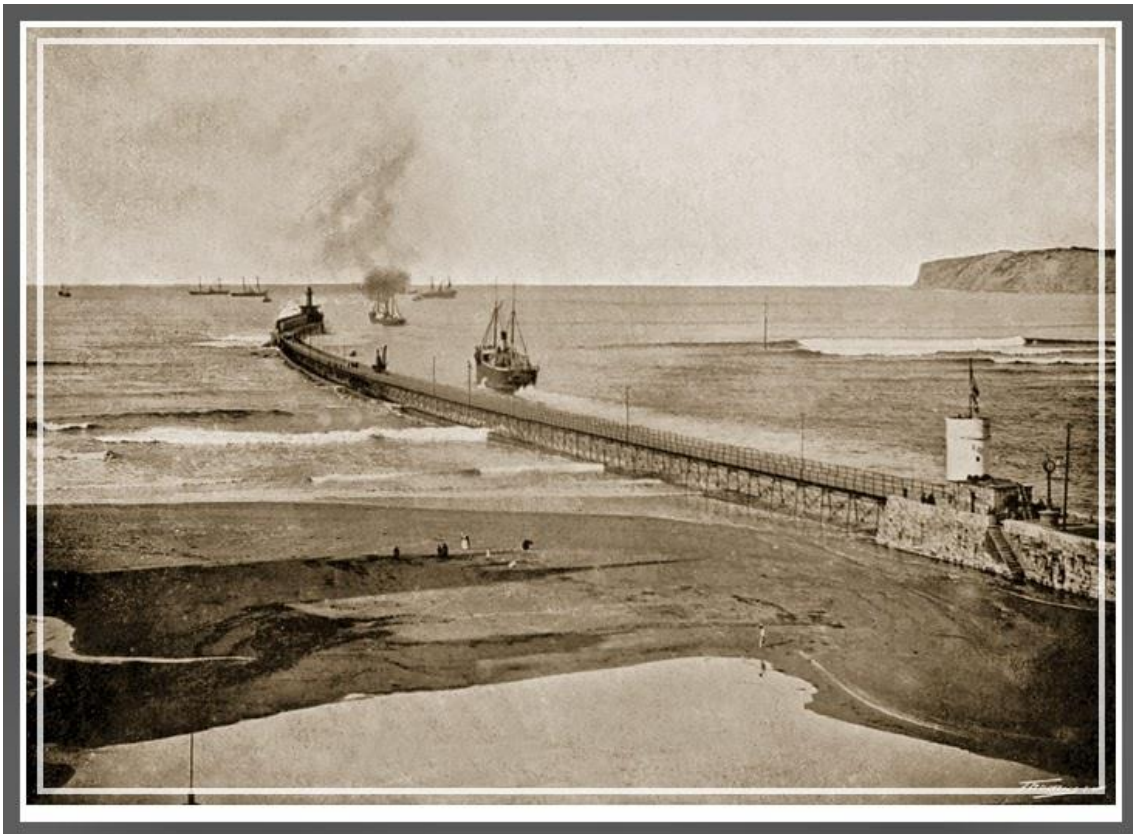
Figura 2.2 Muelle de Hierro y barra de Portugaleta
