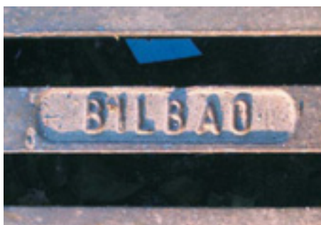
005. Detalle de sumidero.
