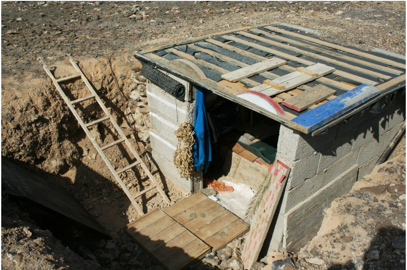
Dispositivo construido en los barrancos. Fuerteventura, 2008.
