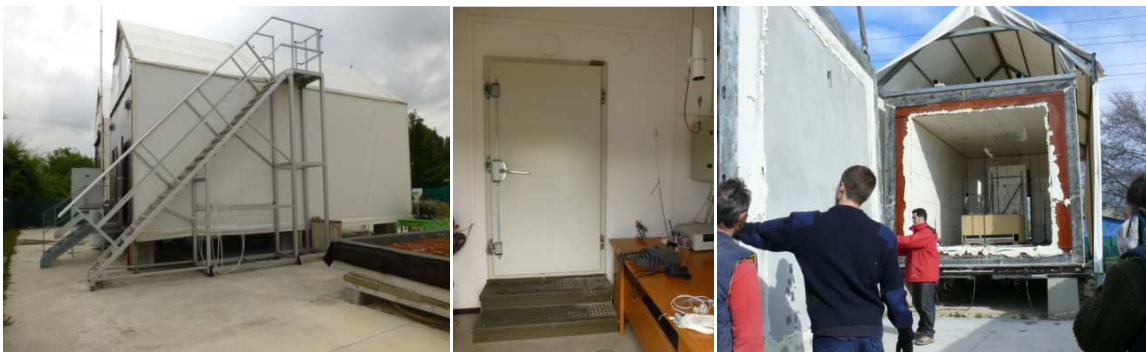
Fig. 3. 15. Izda: Detalle del exterior de la célula Paslink, fachada de orientación oeste. Centro: sala de servicios ,en su interior se encuentra la instrumentación de control de la célula de ensayo. Dcha.: interior de la celda de ensayo sin muestra, fachada de orientación sur
