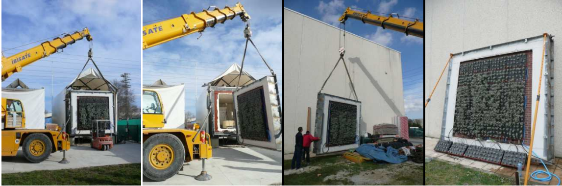
Fig . 4. 4. Tercera fase II: Retirada de la fachada vegetal de la célula Paslink y colocación sobre la pared del LCCE. 04 de marzo de 2013
