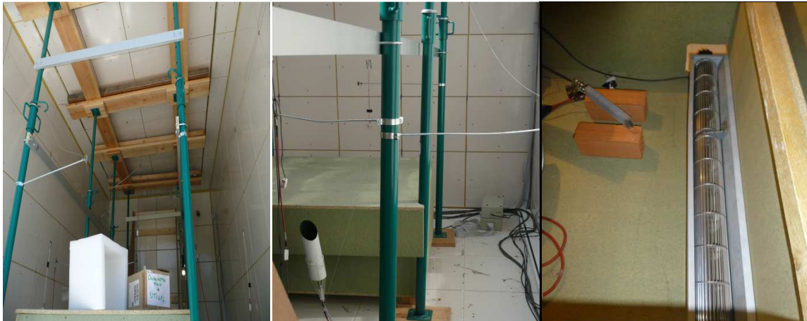
Fig. 3. 17. En las imágenes se muestra la vista frontal de la celda de ensayo ILARGI sin la pared sur donde se coloca la muestra de ensayo. Detalle de los sensores de temperatura de aire y de superficie interior empleados en los ensayos. La caja verde ignífuga contiene las resistencia eléctrica y el ventilador axial que protege de la estratificación de temperatura en el interior de la célula de ensayo.
