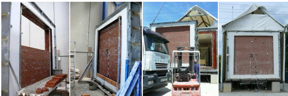
Fig. 4. 1. Primera fase: montaje, traslado y monitorización del muro de hoja doble base del 21 junio al 15 julio de 2012, célula EGUZKI
