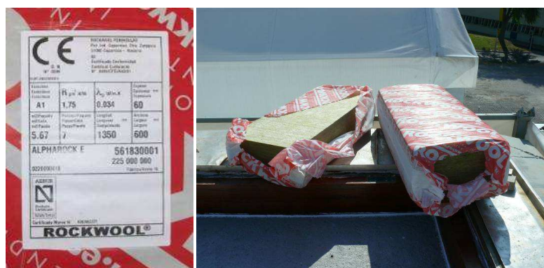
Fig. 3. 8. Aislante utilizado en la fachada ventilada
