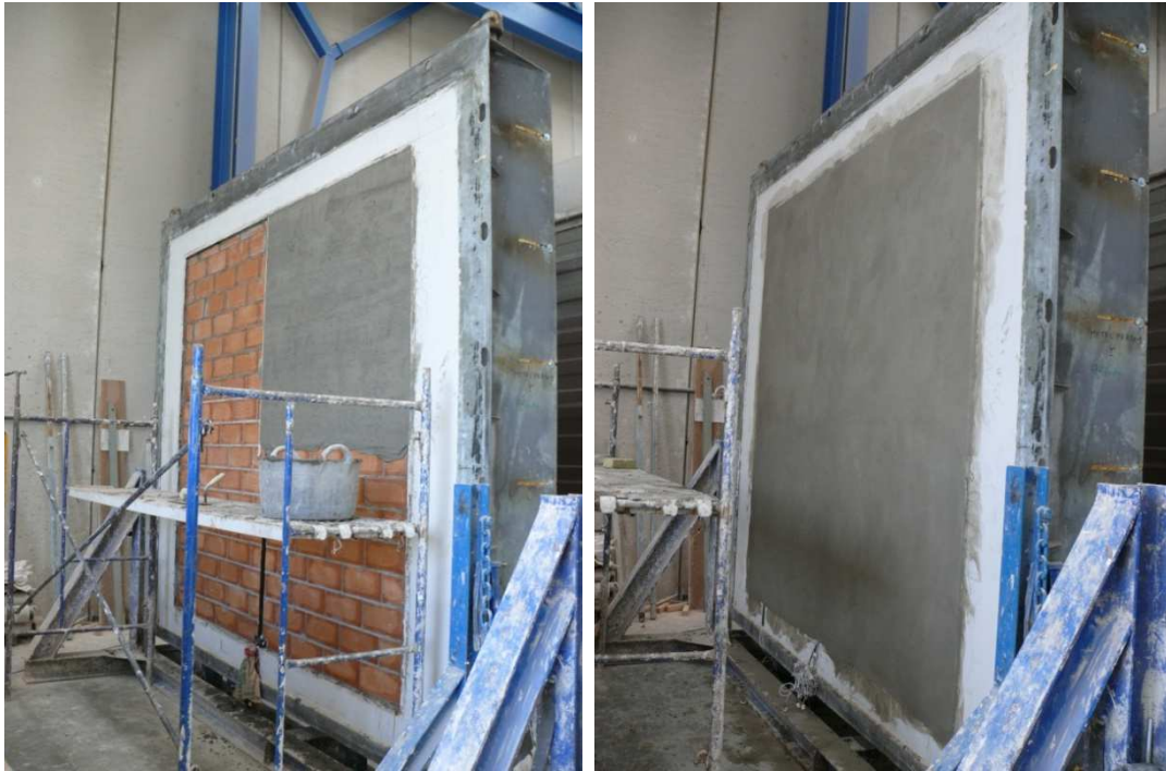
Fig. 3. 6. Fotografía de la aplicación de revestimiento de mortero de cemento sobre el muro base
