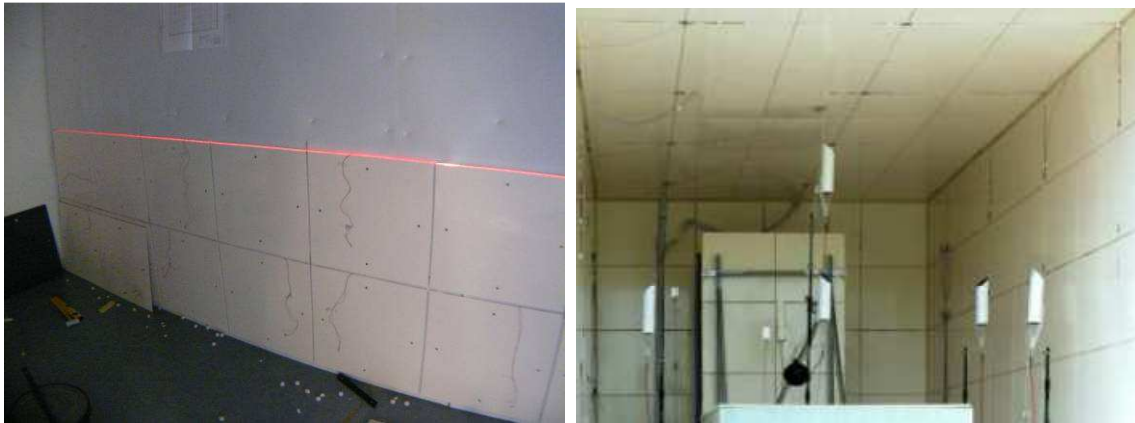
Fig. 3. 39. Izda.) Se pueden observar completamente alineadas e instaladas las HFS Tiles sobre la capa de espuma Dcha.) las paredes y techo recubiertos por las Tiles
