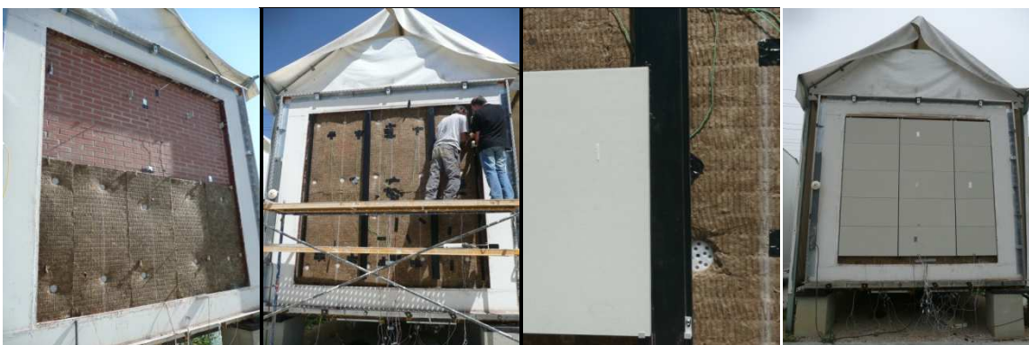
Fig. 4. 2. Segunda fase: montaje de la fachada ventilada cerámica sobre el muro base y monitorización de esta del 01 al 31 de agosto de 2012. Célula EGUZKI
