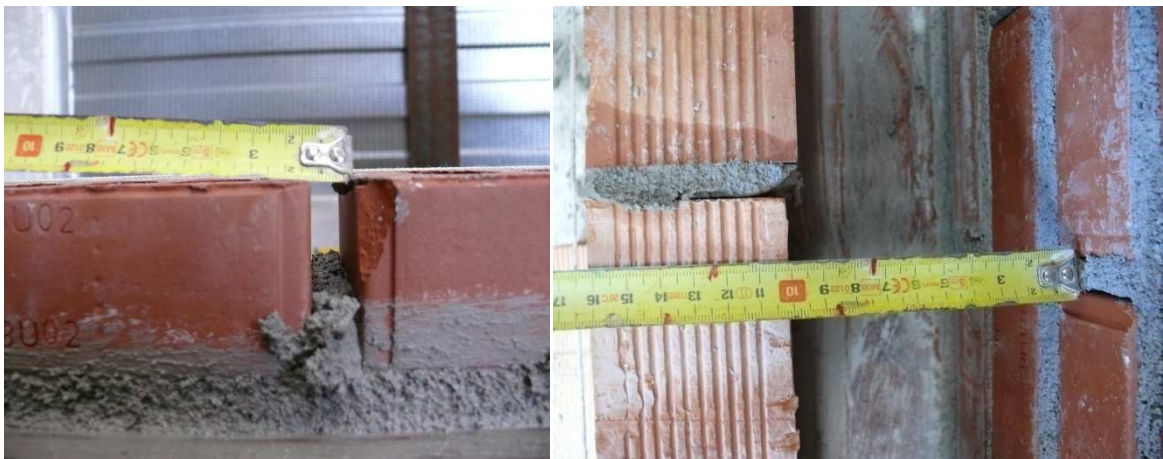
Fig. 3. 3. Detalle del ladrillo caravista y de la cámara de aire
