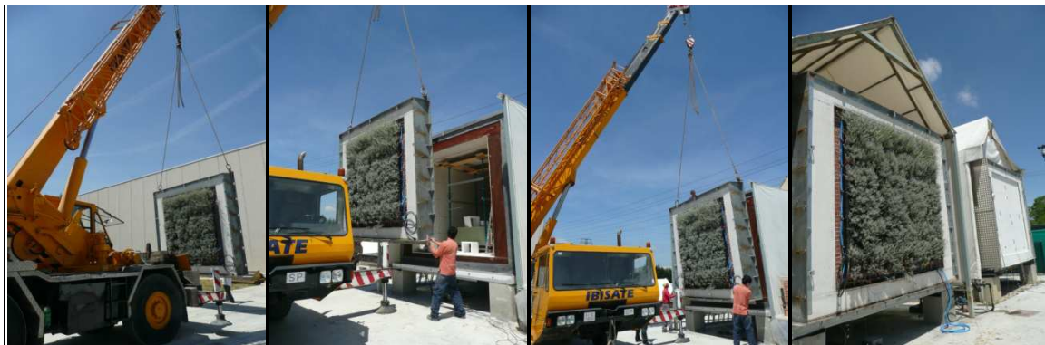
Fig . 4. 5. Tercera fase III: 28 de junio de 2013 colocación de la fachada vegetal en la célula ILARGI y monitorización hasta diciembre 2014
