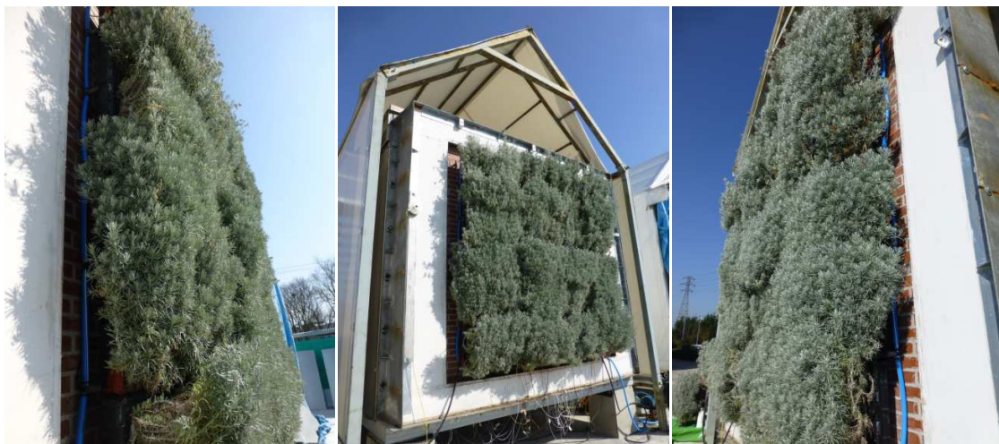
Fig. 4. 26. Detalle de la fachada vegetal en Febrero de 2014 durante los ensayo PRBS en la célula de ensayo ILARGI
