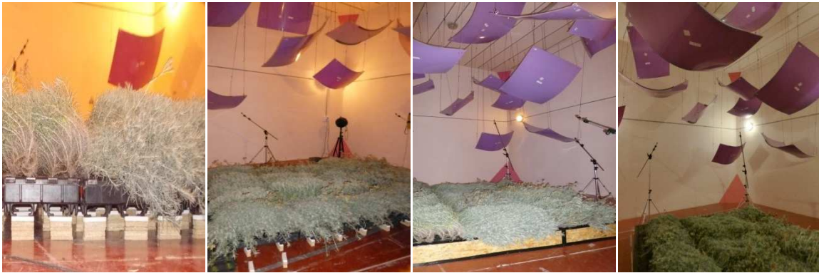
Fig. 6. 7. Resumen fotográfico de la construcción del marco y colocación de las muestras para la realización del ensayo de absorción acústica
