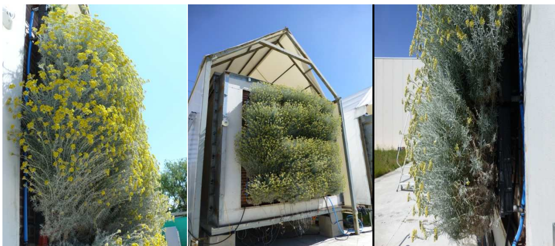
Fig. 4. 29. Detalle de la fachada vegetal en Mayo de 2014 durante los ensayo PRBS en la célula de ensayo ILARGI
