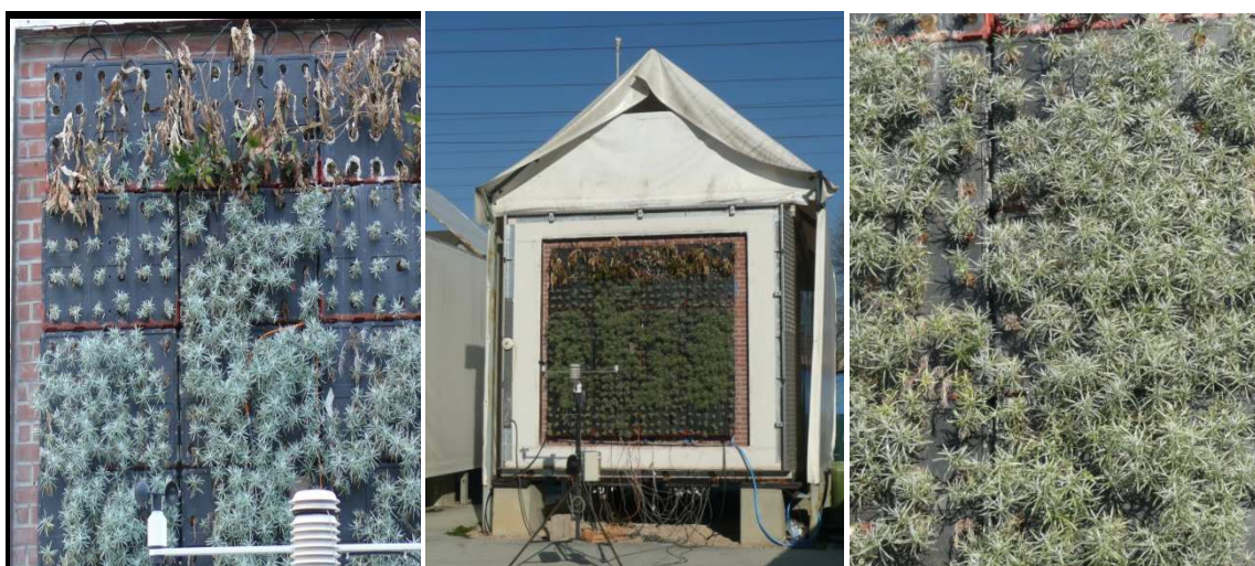
Fig. 4. 14. Detalle de la fachada vegetal en Enero de 2013 durante el ensayo PRBS en la célula de ensayo EGUZKI.
