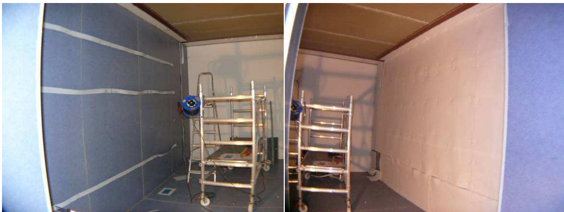
Fig. 3. 38. Izda.) Conexión de las Tiles en serie mediante cables planos .Dcha.) Vista de los paneles de espuma instalada para garantizar la homogeneidad del flujo de calor
