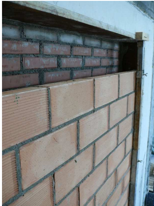
Fig. 3. 2. Detalle del ladrillo hueco doble con cámara de aire y ladrillo caravista
