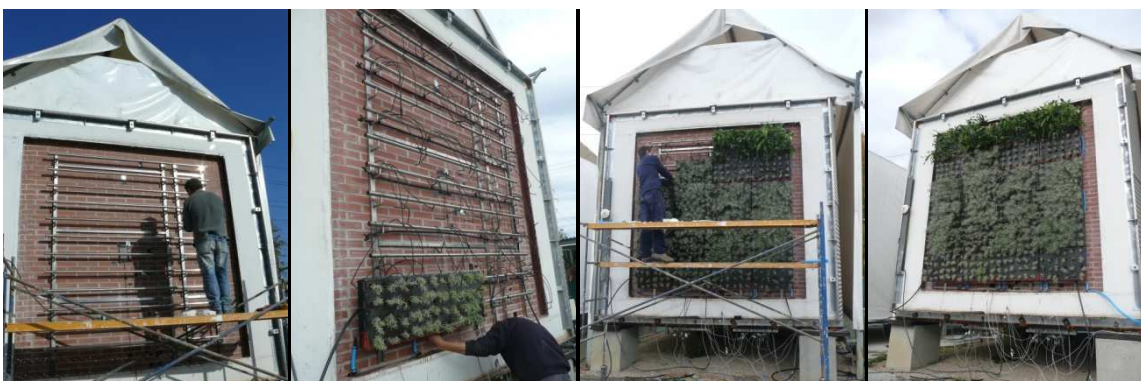
Fig. 4. 3. Tercera fase I: montaje de la fachada vegetal sobre el muro base y monitorización de esta del 01 de diciembre de 2012 al 03 de marzo de 2013. Célula EGUZKI
