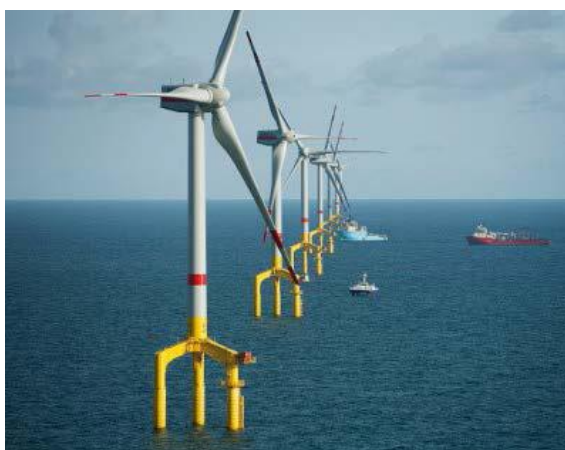
Figura 71. Cimentación por tripilote
