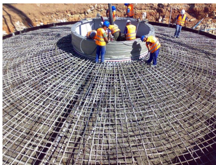
Figura 65. Hormigonado de la cimentación
