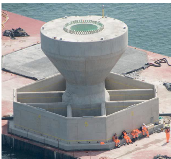
Figura 68. Cimentación por gravedad
