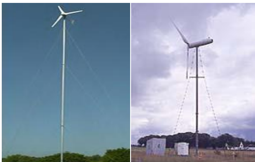
Figura 55. Torre con tensores
