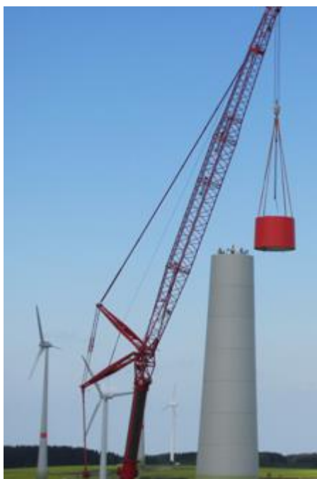
Figura 63. Torre de hormigón prefabricado
