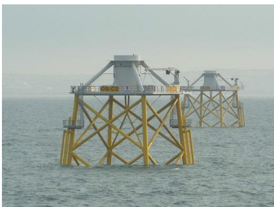
Figura 72. Cimentación por jacket
