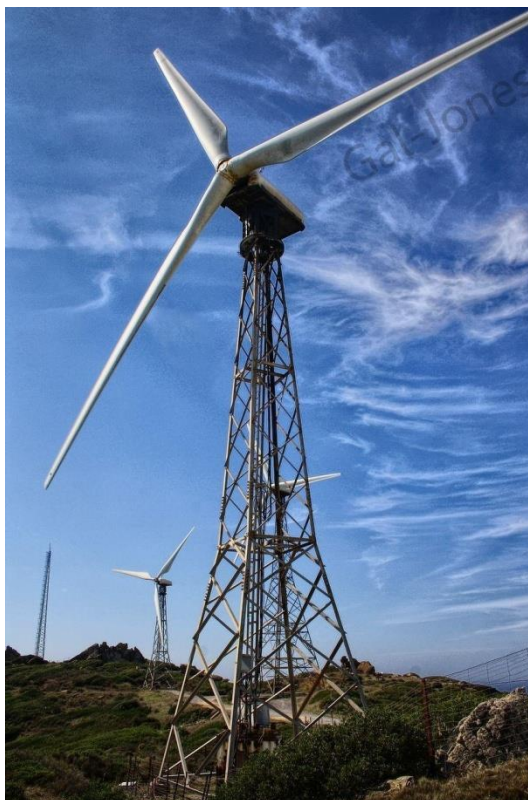
Figura 54. Torre en celosía
