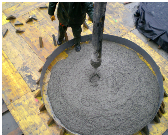
Figura 9. Hormigonado de prototipos loseta circular.
