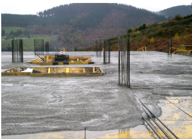
Figura 2. Hormigonado de planta estructural.
