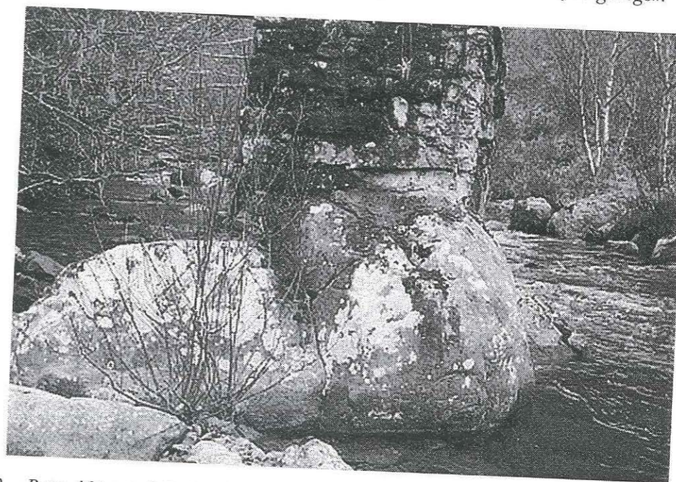
IMAGEN 2. Restos del puente de Baulatabla sobre el río Engaña.
