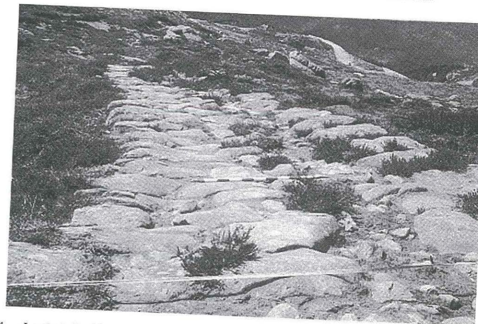
IMAGEN 1. La vía de La Engaña en el tramo junto al Alto de la Varga.
