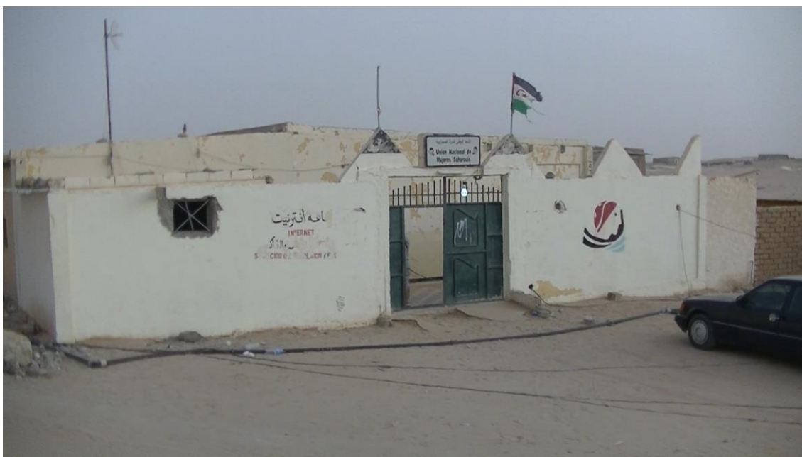
Sede principal de la UNMS, en Boujdour
