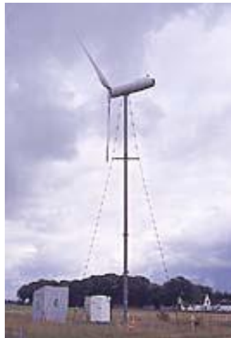
Figura 62: Torre con tensores.
