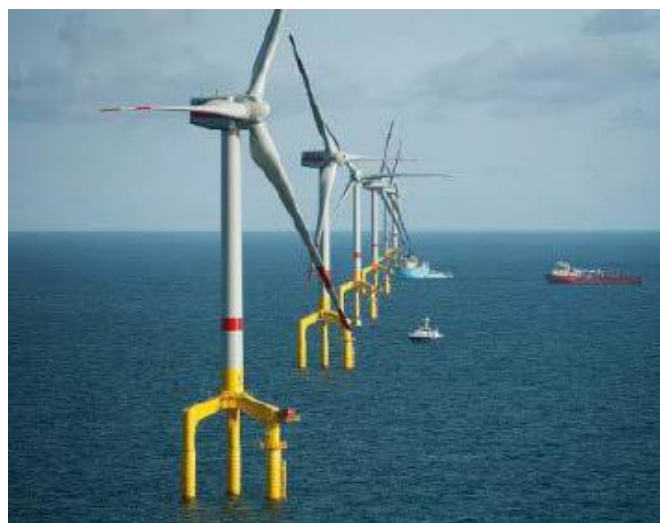
Figura 74: Cimentación por tripilote.
