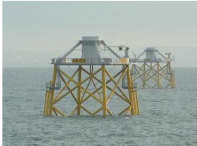
Figura 75: Cimentación por Jacket.
