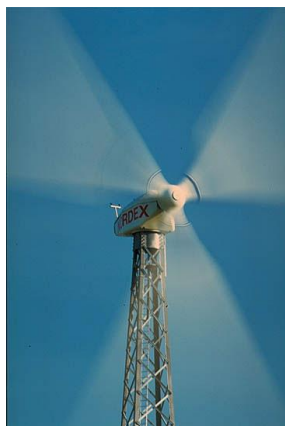
Figura 61: Torre de celosía.
