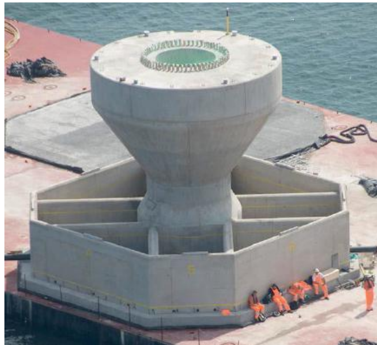
Figura 71: Cimentación por gravedad.
