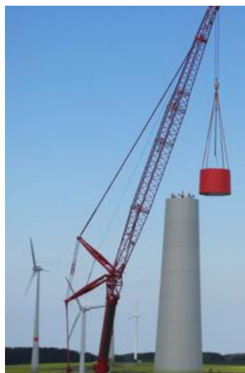
Figura 66: Torre de hormigón prefabricado.
