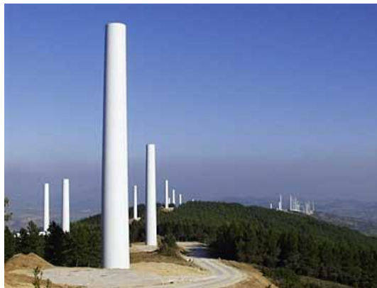
Figura 63: Torres tubulares.
