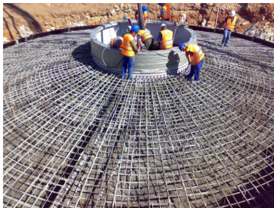
Figura 68: Hormigonado de la cimentación.
