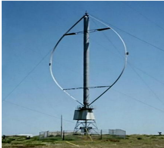
Figura 26: Rotor Darrieus
