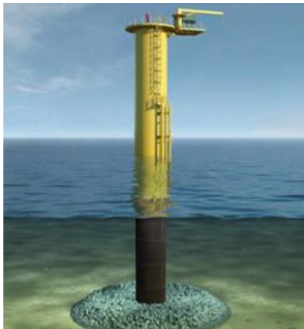
Figura 72: Cimentación por monopilote.
