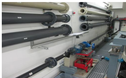
Fotografía 2-16 Zona de ensayo grande
