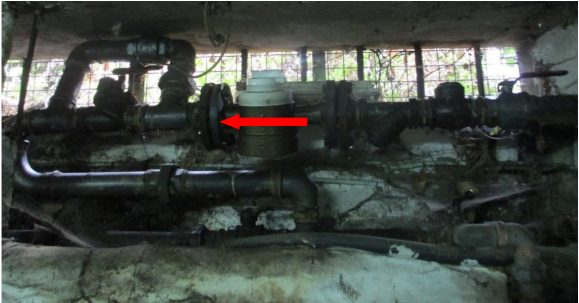
Figura 32. Foto de la instalación original del contador en Z-A17 (FP), Z.
