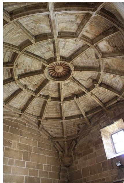
Samaniego. Parroquia de la Asunción. Sacristía. Cubierta
