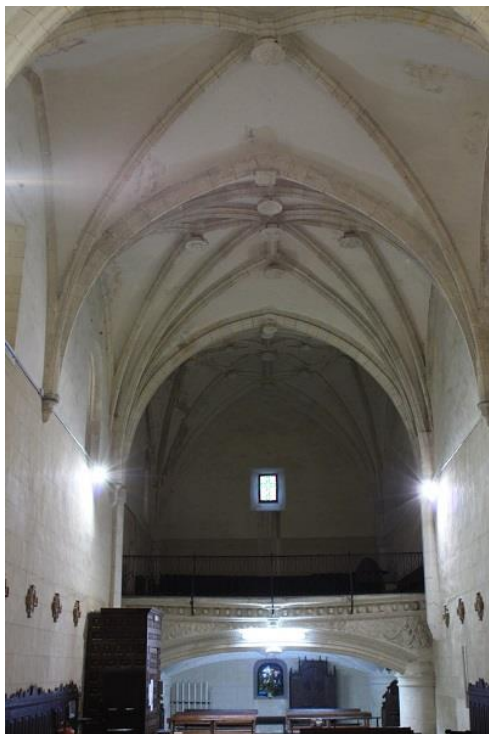
Erenchun. Parroquia de San Andrés. Nave de la iglesia
