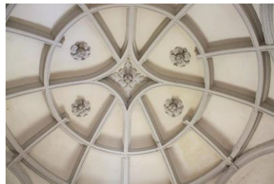
Yurre. Parroquia de Santiago. Sacristía. Cubierta
