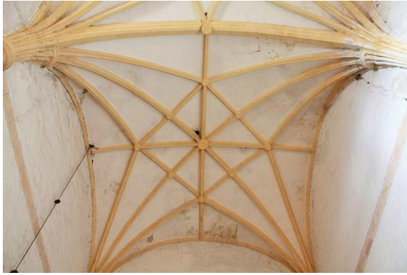
Chinchetru. Parroquia de Santa Eulalia. Nave de la iglesia. Segundo tramo. Bóveda
