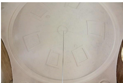
Laguardia. Parroquia de Santa María. Sacristía. Bóveda.
