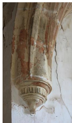
Muergas. Parroquia de San Cosme y San Damián. Nave de la iglesia. Cabecera y primer tramo
