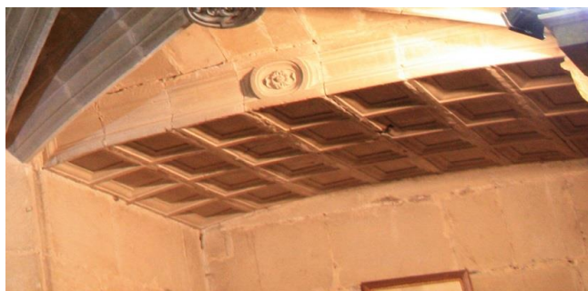
Yécora. Parroquia de San Juan. Sotocoro. Capilla lateral. Bóveda
