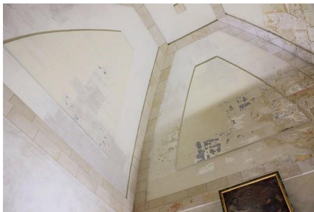
Erenchun. Parroquia de San Andrés. Sacristía. Bóveda
