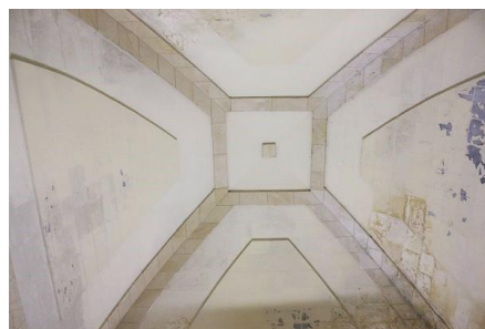
Erenchun. Parroquia de San Andrés. Sacristía Cubierta. Detalle
