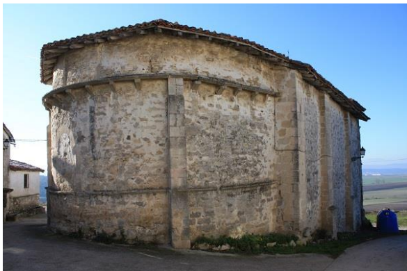
Busto. Parroquia de San Cipriano y Santa Justina. Exterior. Cabecera y nave
