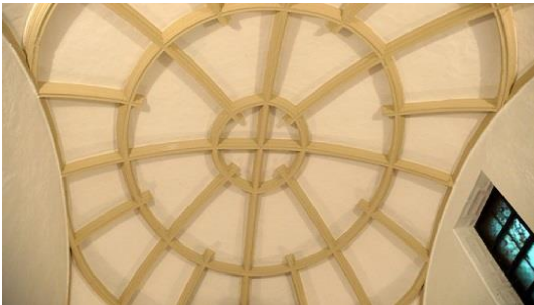
Zurbano. Parroquia de San Esteban. Sacristía. Cubierta
