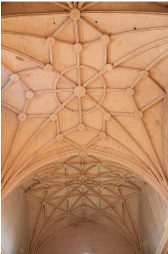
Ilárraza. Parroquia de Santa Eulalia. Primer y segundo tramo de la nave. Cubiertas
