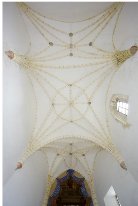
Villanañe. Parroquia de la Asunción. Bóvedas
