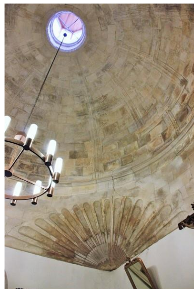
Alegría. Parroquia de San Blas. Sacristía. Cubierta
