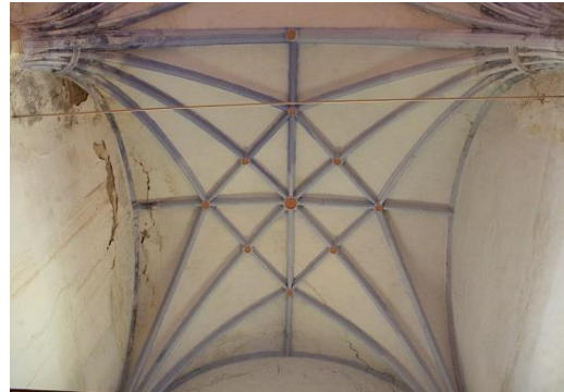
Ocáriz. Parroquia de Nuestra Señora. Nave de la iglesia. Último tramo. Bóveda
