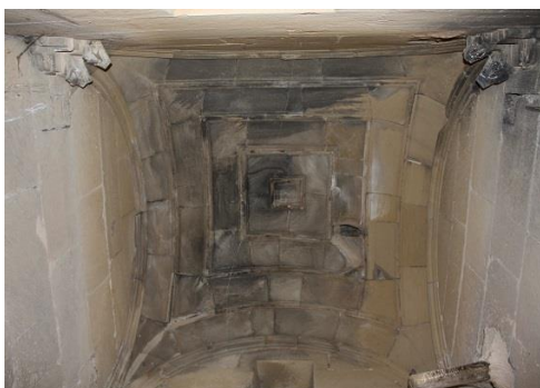
Yécora. Parroquia de San Juan. Subida a la torre. Bóveda baída
