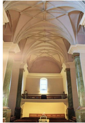
Apodaca. Parroquia de San Martín. Nave de la iglesia. Cubiertas
