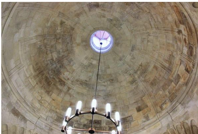
Alegría. Parroquia de San Blas. Sacristía. Cubierta
