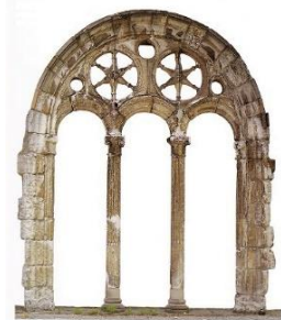
Vitoria. Residencia San Prudencio. Arco del claustro del convento de Santo Domingo (desaparecido)
