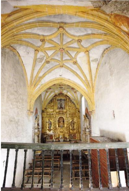
San Esteban de Treviño. Parroquia de San Esteban. Nave de la iglesia. Primer tramo. Bóveda
