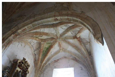
Muergas. Parroquia de San Cosme y San Damián. Nave de la iglesia. Cabecera y primer tramo
