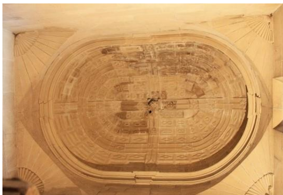
Elciego. Parroquia de San Andrés. Caja de escaleras de subida al coro alto. Bóveda
