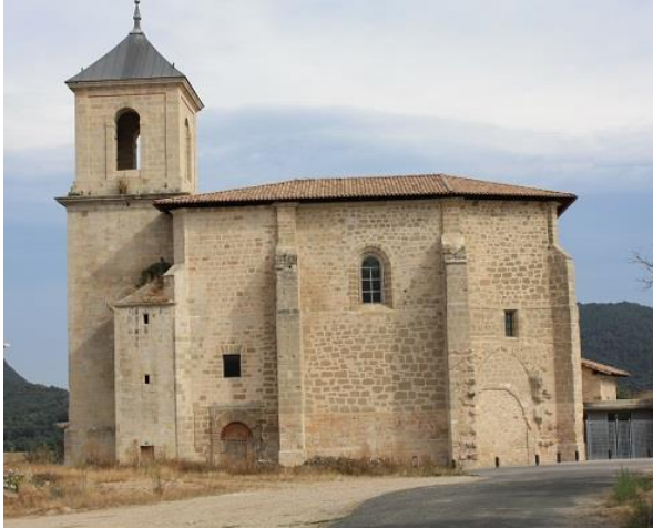
Villanañe. Parroquia de la Asunción. Exterior. Costado sur
