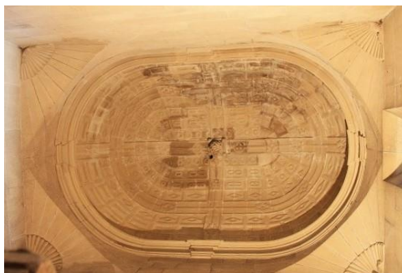
Elciego. Parroquia de San Andrés. Caja de escaleras de subida al coro alto. Bóveda
