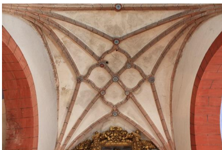
Arrieta. Parroquia de San Esteban. Primer tramo. Bóveda
