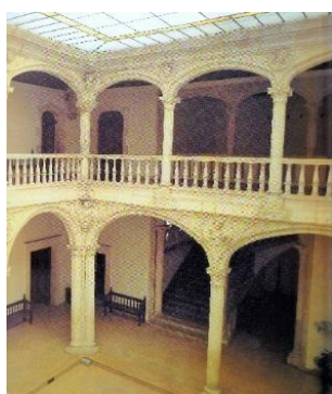
Vitoria. Palacio Escoriaza-Esquível. Patio
