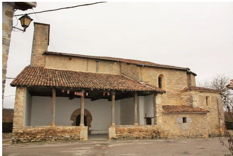
Guereña. Parroquia de San Juan. Exterior. Costado sur
