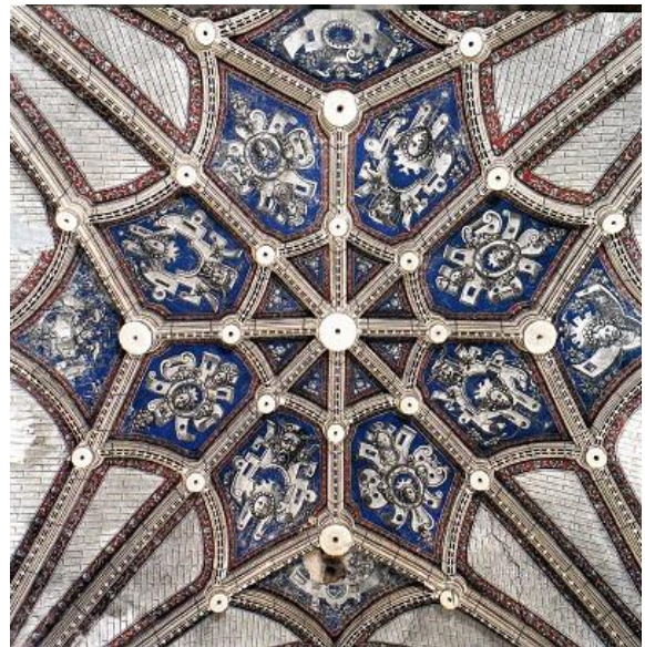
Urbina. Parroquia de San Antolín. Bóveda sobre el coro
