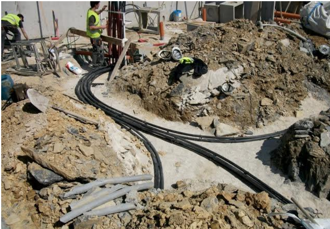
Imagen 14 Operarios instalando las conducciones horizontales del sistema geotérmico
