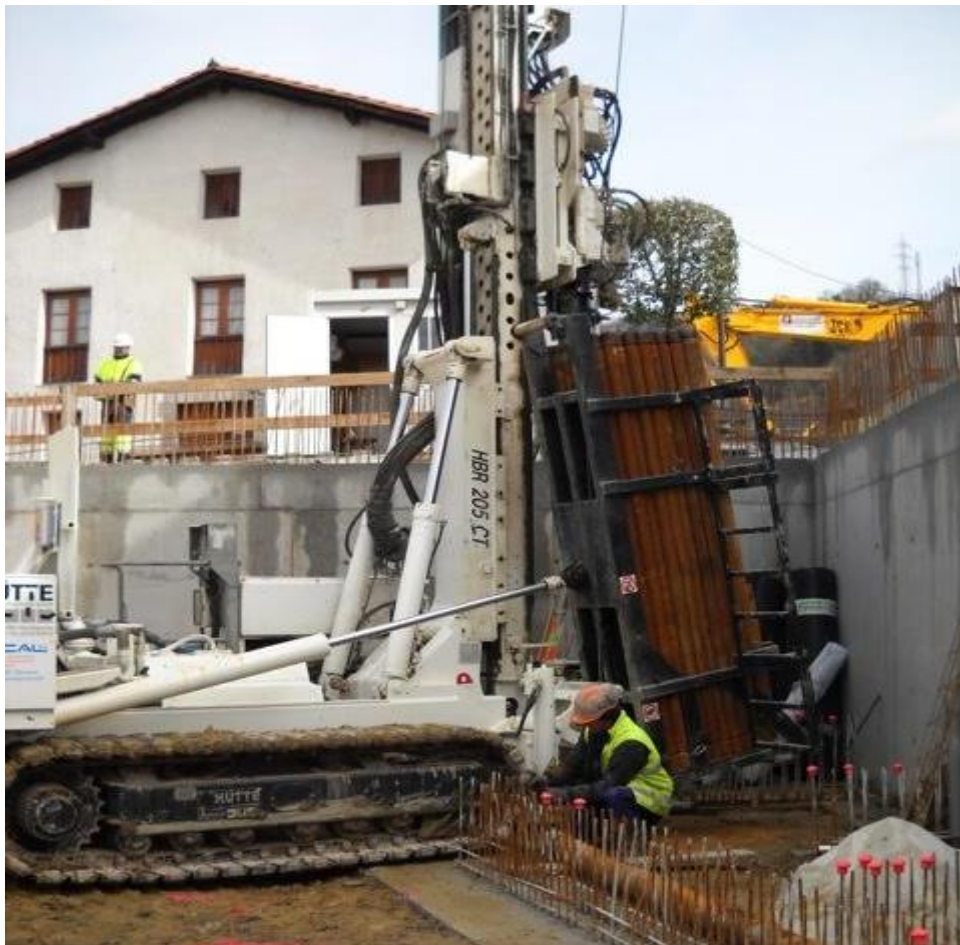
Imagen 13 Operarios trabajando en las labores de perforación de los sondeos
