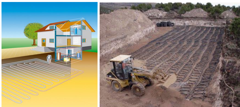
Imagen 8 Ilustración y fotografía de un circuito cerrado horizontal
