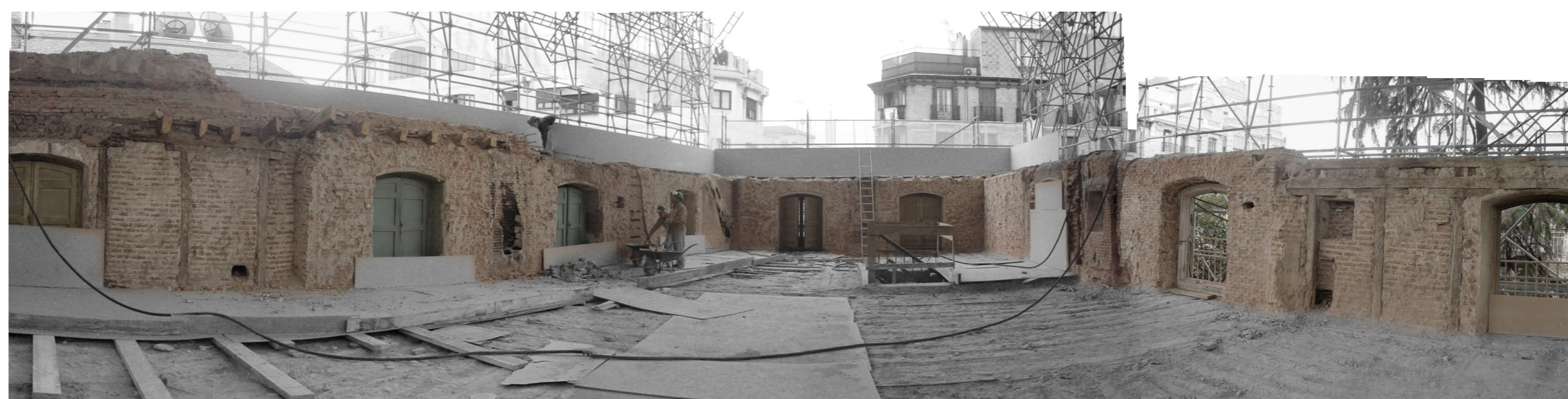
La oportunidad de coronación del edificio
