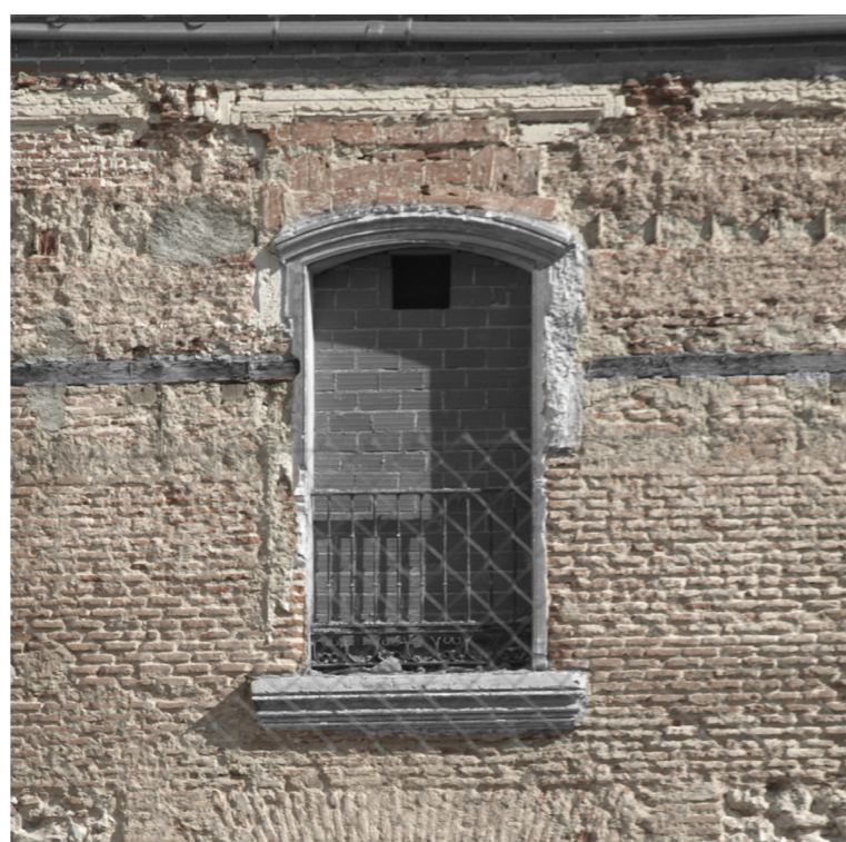
El cerramiento original de fábrica de ladrillo
