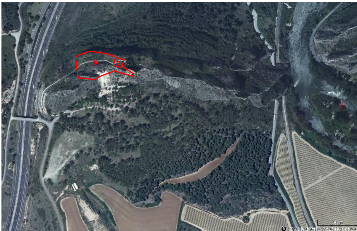
Fig. 2.- Vista de detalle del risco situado entre el río Ebro –a la derecha- y la autopista –a la izquierda- en la que se han señalado: (a) el área de trabajo en la que se localiza el muro defensivo y (b) la zona en la que se han documentado los restos de estructuras y retalles (imagen base tomada de IDERioja).
