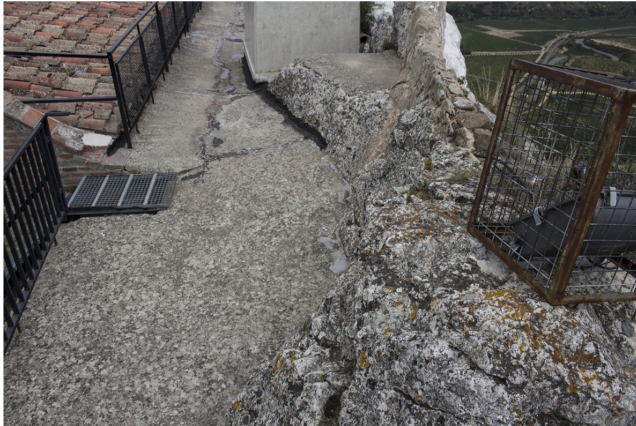
Fig. 32.- Espacio situado sobre el tejado de la ermita y a los pies de la estatua del santo.
