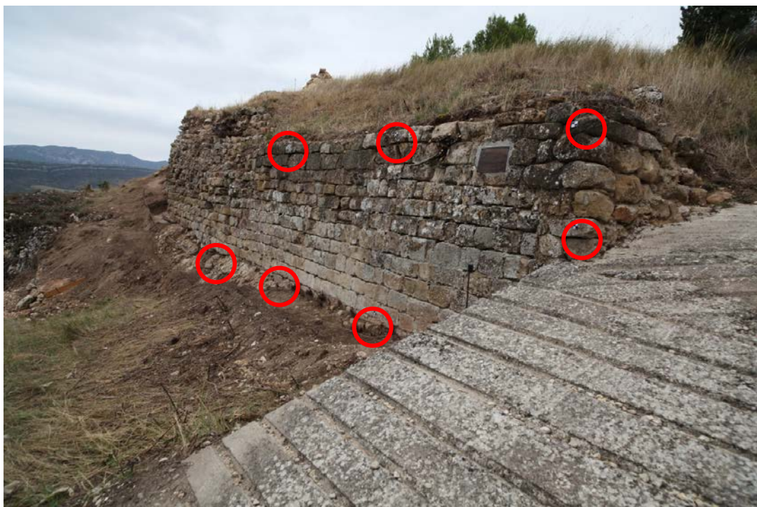
Fig. 7.- Dianas situadas sobre la cara exterior de la muralla.
