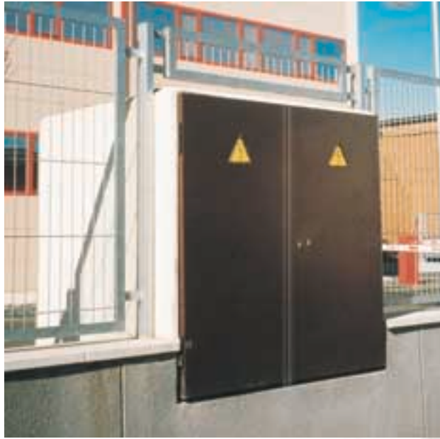
PF-15 con acceso desde la vía pública
