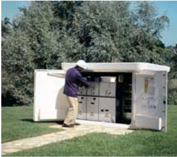
Apararata de MT y BT de un MINIBLOK
