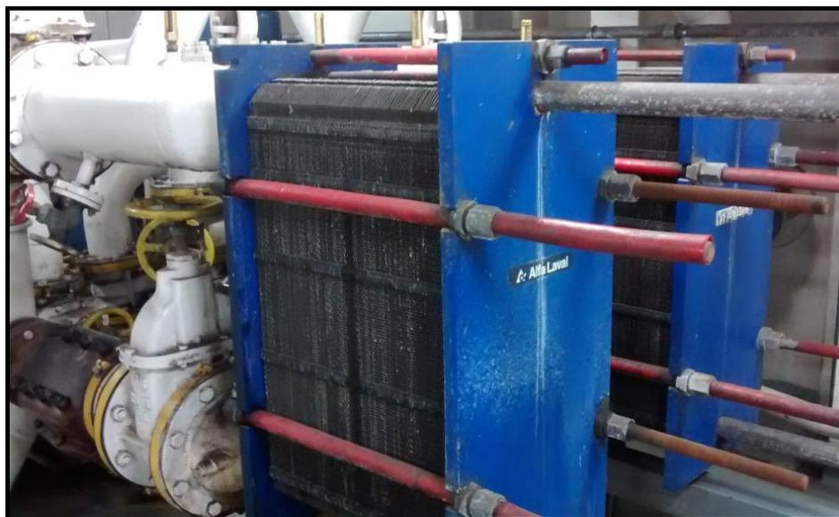
Figura 77. Intercambiador de aceite de lubricación de motor del buque Sorolla.
