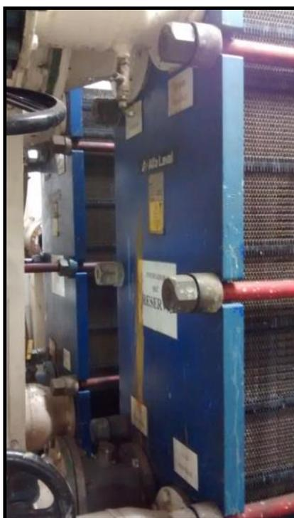
Figura 76. Intercambiador de placas para el agua de refrigeración de los motores en el buque Sorolla.
