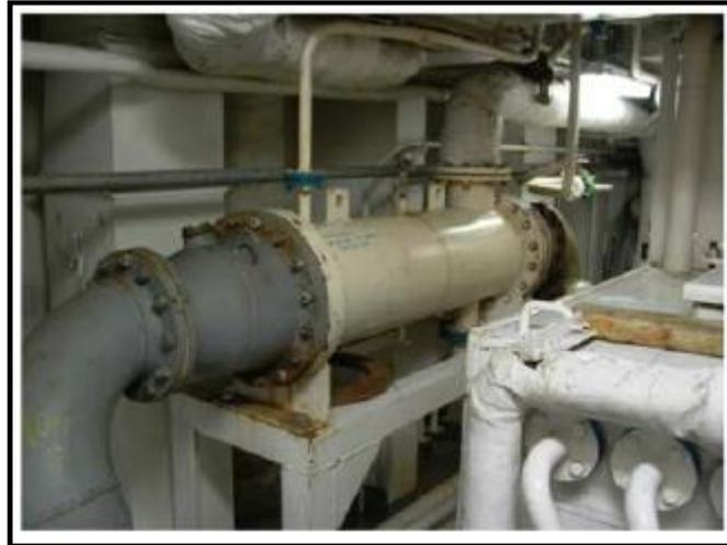
Figura 78. Condensador de vapor sobrante en el buque Sorolla.
