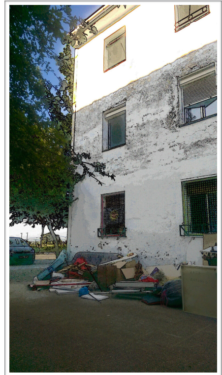
Ilustración 22: Objetos abandonados en una de las viviendas de Errekaleor 2015 (Fuente: elaboración propia)
