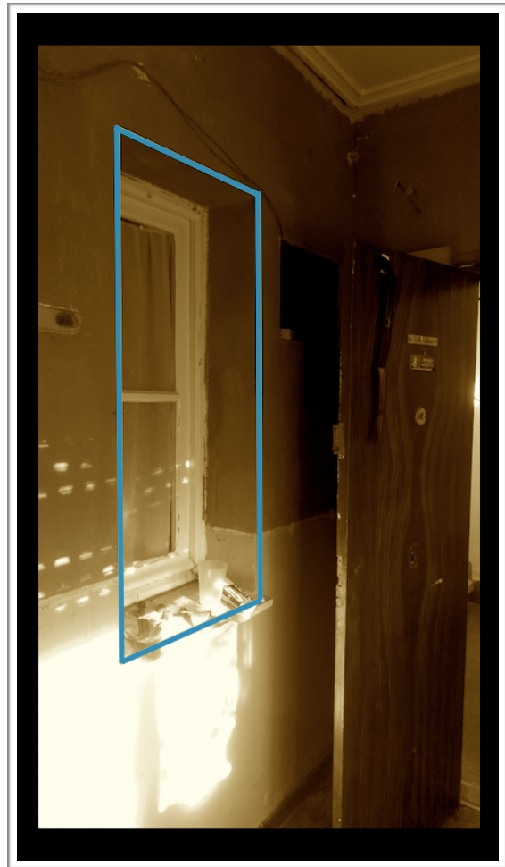
Ilustración 19: Ventana del servicio en el interior de una vivienda (Fuente: elaboración propia)
