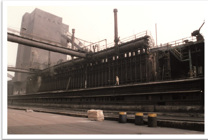
Batería de coke – Altos Hornos de Vizcaya (by Miguel Ángel Martínez Vitores)
