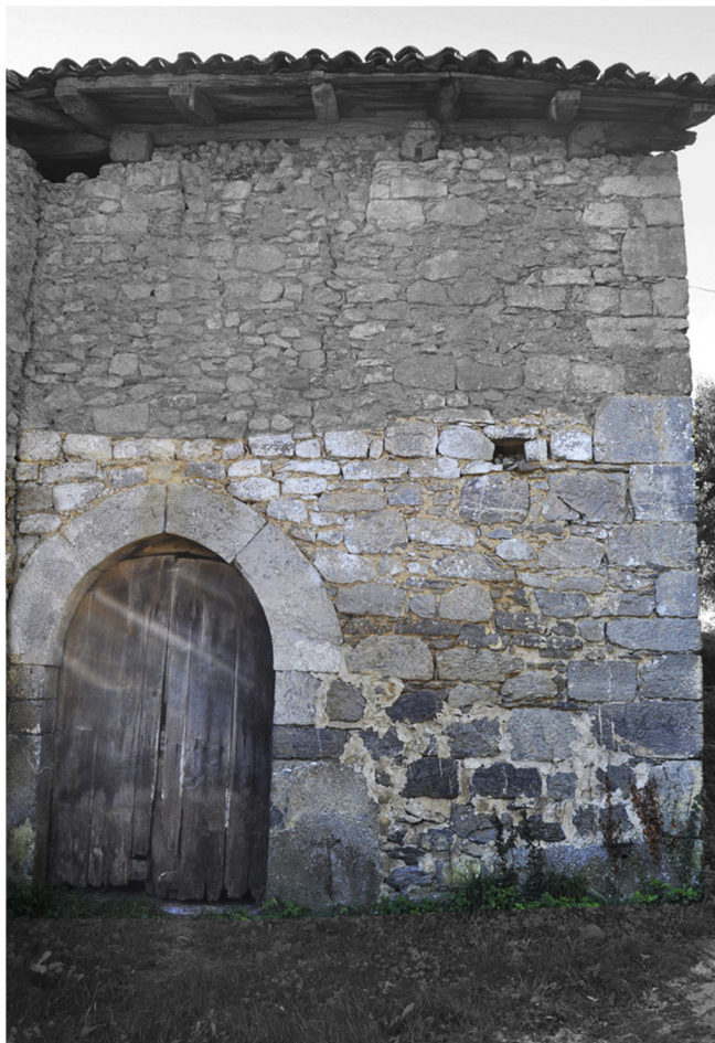
Lehenengo eraikuntza fasea ukuiluko itxiturretan.
