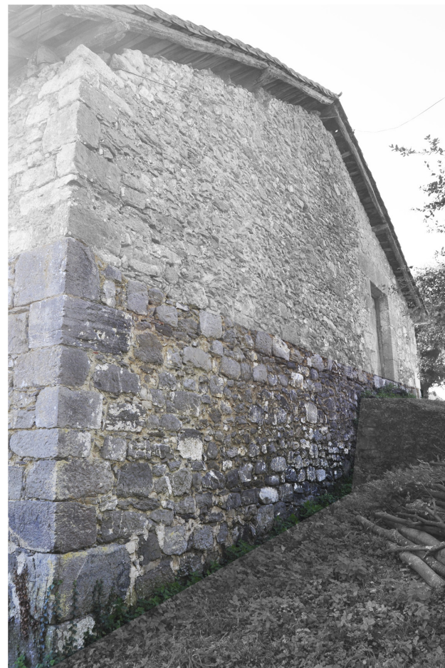
Lehenengo eraikuntza fasea ukuiluko itxiturretan.
