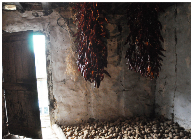
32. ird. Lehenengo solairua, egongela zena.
