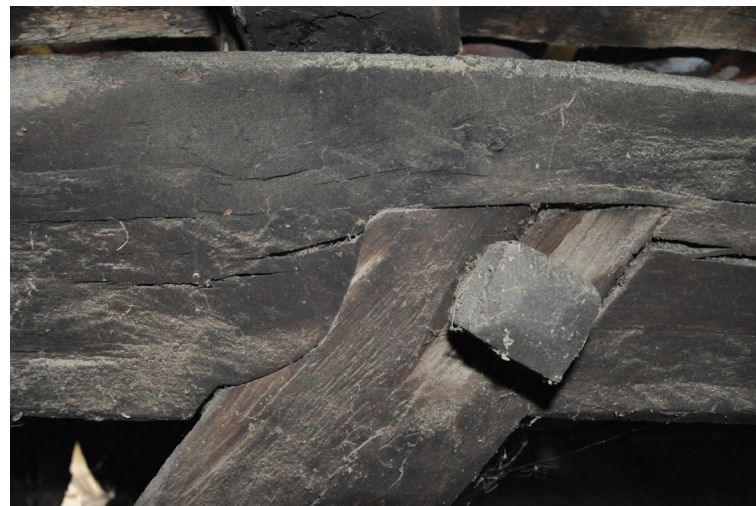
46. ird. Zurezko egitura elementuen arteko ziri bidezko lotura xehetasuna.
