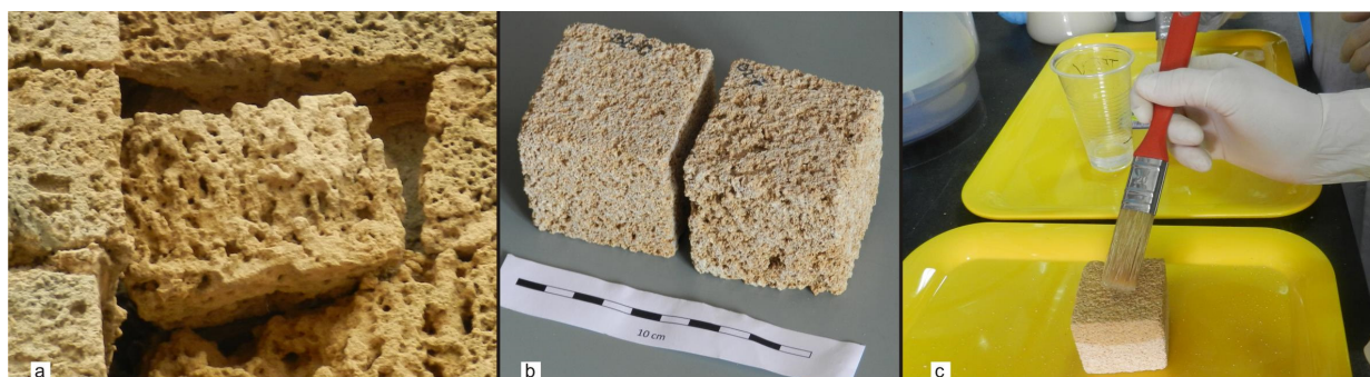
Fig. 2. a) bloco desprendido da fachada da Fortaleza; b) amostras cortadas; c) aplicação dos tratamentos consolidantes com pincel.
