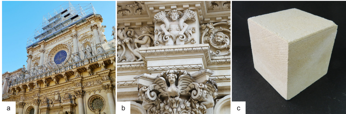
Figura 5. Piedra de Lecce (caliza de Italia). a) Iglesia de la Santa Cruz (Lecce, Italia) [Ina Van Hateren] © 123RF.com; b) Detalles ornamentales de la Iglesia de la Santa Cruz [jorisvo] © 123RF.com; c) Probetas de 5x5x5 cm utilizadas en los ensayos realizados en laboratorio de piedra de Lecce.
