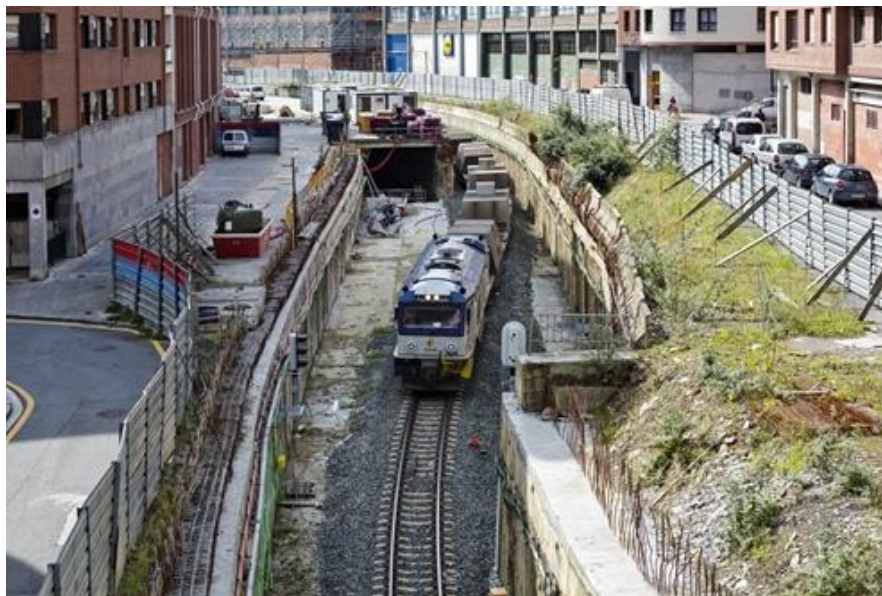
Figura 12. Tamo de vía perteneciente a la Calle Jaén
