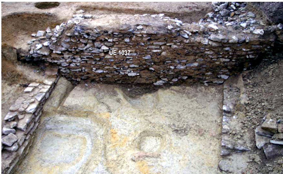
Figura 48. Detalle de la reconstrucción del muro del sótano tras el primer colapso
