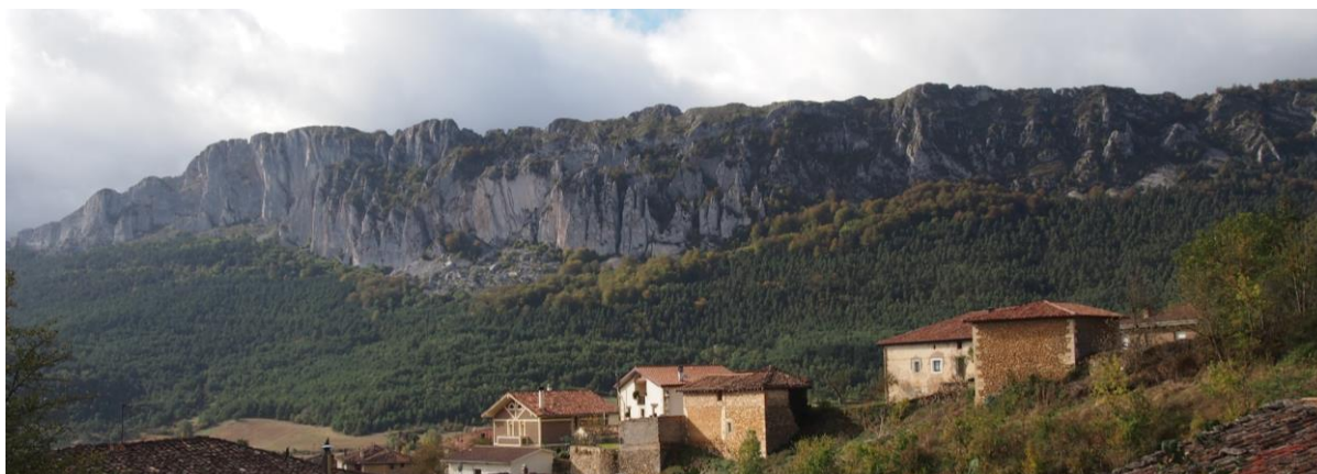
Figura 3.46. Vista general de la vertiente nororiental de Peña Carria y la sierra de Peña Gobeia desde la localidad de Corro. Hacia la parte central-izquierda de la imagen se observan los grandes bloques desprendidos por vuelco, así como su área fuente, localizada en el escarpe superior (de tonos más amarillentos).
