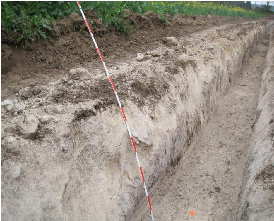
Figura 3.109. Perspectiva de un tramo de las zanjas de regadío abiertas en el valle de Pinedo-Basabe.
