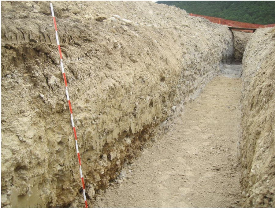
Figura 3.1. Perspectiva de un tramo de las zanjas de regadío abiertas en la llanura aluvial del Omecillo.
