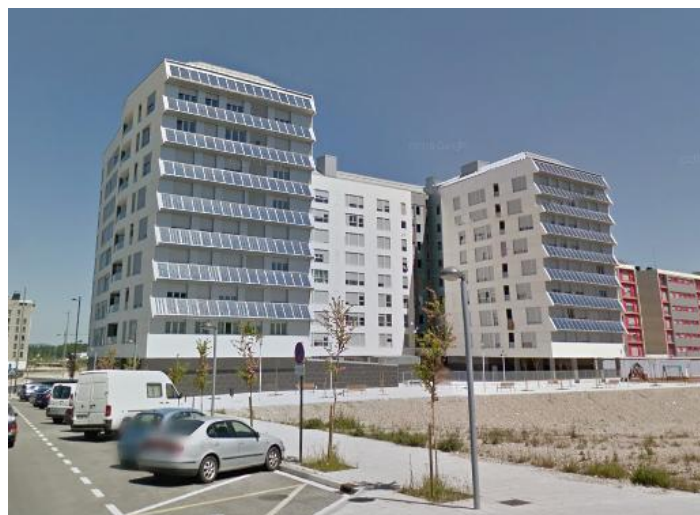
FIGURA 4. EDIFICIO DE 171 VIVIENDAS EN SALBURUA, VITORIA
