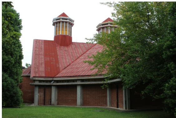
Cubierta metálica sujeta por la estructura espacial sobre los pilares de hormigón y las fachadas de ladrillo caravista. Fotografías de la autora.
