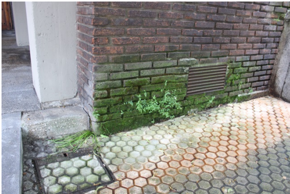
Colonias de microorganismos y vegetación en el exterior (izda.) y manchas de orina en el porche (dcha.). Fotografías de la autora.
