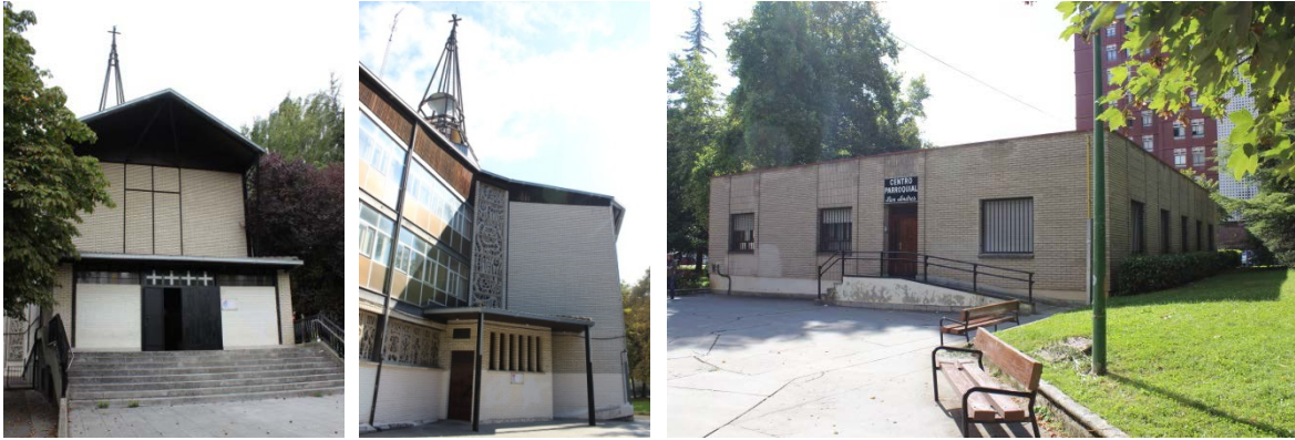
Imágenes exteriores del templo (izda. y centro); a la derecha, el centro parroquial. Fotografías de la autora.
