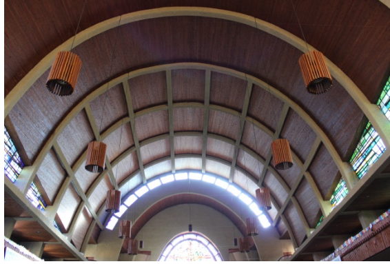
Detalle del esqueleto de arcos de hormigón que sujetan la cubierta.
