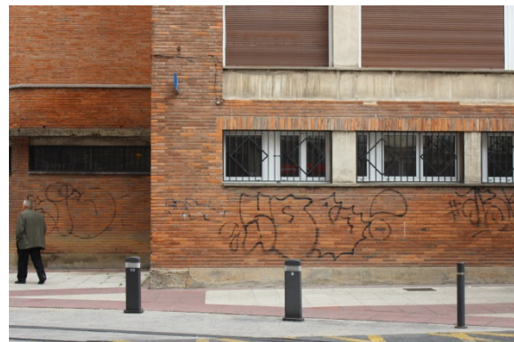
Porche de hormigón con carbonataciones (izda.) y muros de fábrica en los que han aparecido zonas oscuras debido a la humedad, grafitis y desprendimiento de ladrillos (dcha.).
