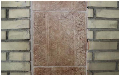
Unas baldosas cerámicas ocultan tras ellas las piezas estructurales de hormigón y los detalles de cemento. Fotografías de la autora.
