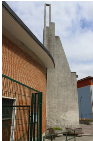
Torre de hormigón, de formas poligonales, en contraposición a las formas curvas del volumen de la iglesia. Fotografía de la autora.
