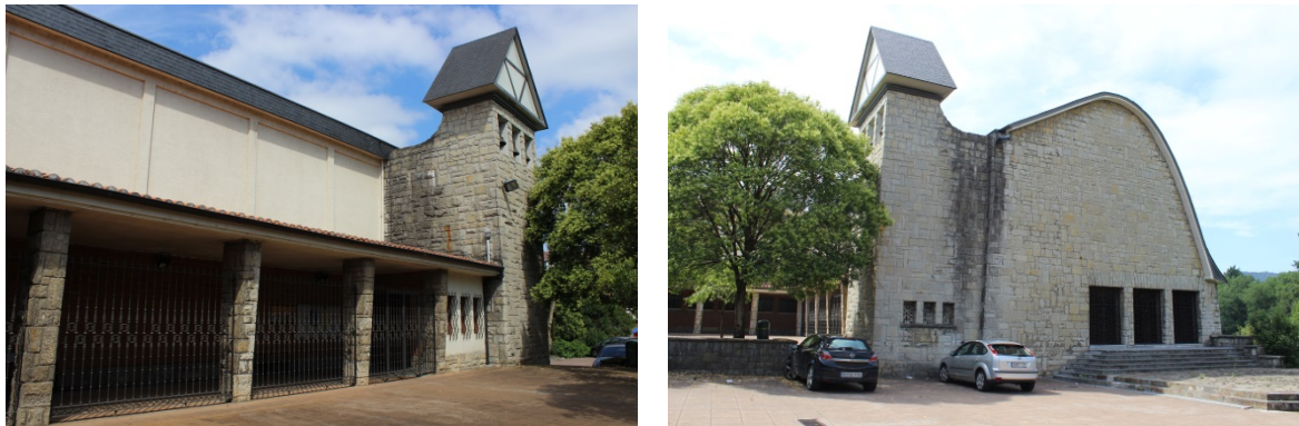
Imágenes exteriores de la iglesia de Usansolo en la actualidad: accesos y campanario. Fotografías de la autora.
