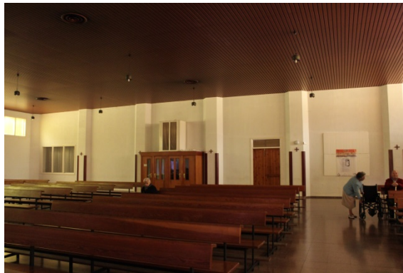
Fondo de la iglesia en el que se distingue la estructura vertical; la horizontal queda tapada por el falso techo. Fotografía de la autora.
