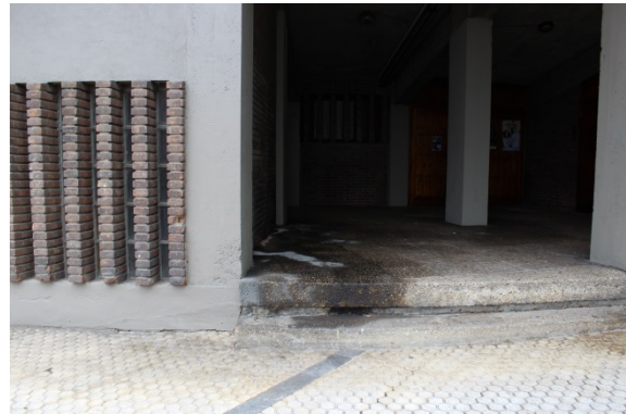
Colonias de microorganismos y vegetación en el exterior (izda.) y manchas de orina en el porche (dcha.). Fotografías de la autora.
