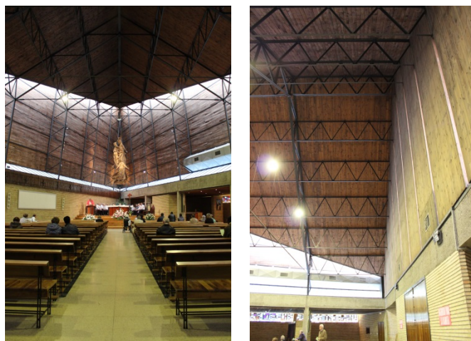
Estructura de la cubierta vista desde el interior, compuesta por unas cerchas triangulares y planas.
