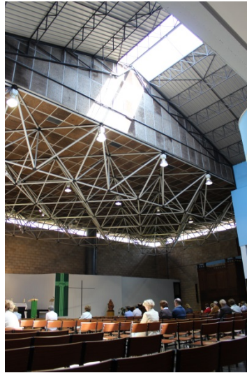
Estructura metálica que permite la iluminación natural y sujeta la artificial.
