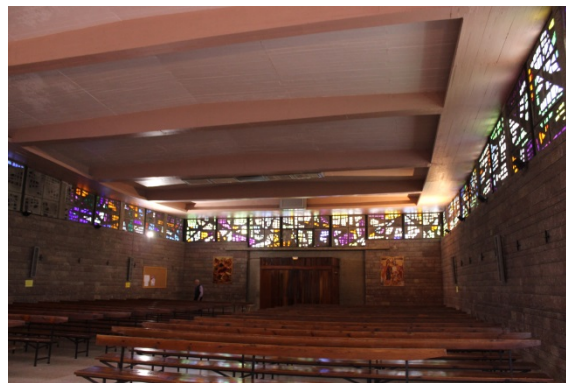
Imágenes interiores de la iglesia donde se puede observar la estructura de la cubierta. Fotografía de la autora.
