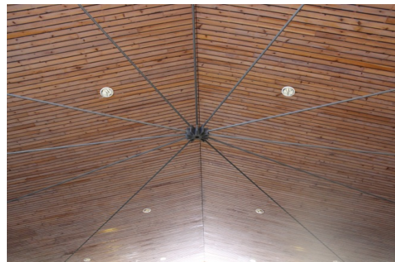
El techo de madera laminada permite percibir la forma de la cubierta, compuesta por dos planos inclinados; la cumbrera asciende hacia el presbiterio. Para soportar los empujes horizontales y evitar que la estructura de cubierta se abra, se instalan once cables que sobresalen de las láminas del techo.
