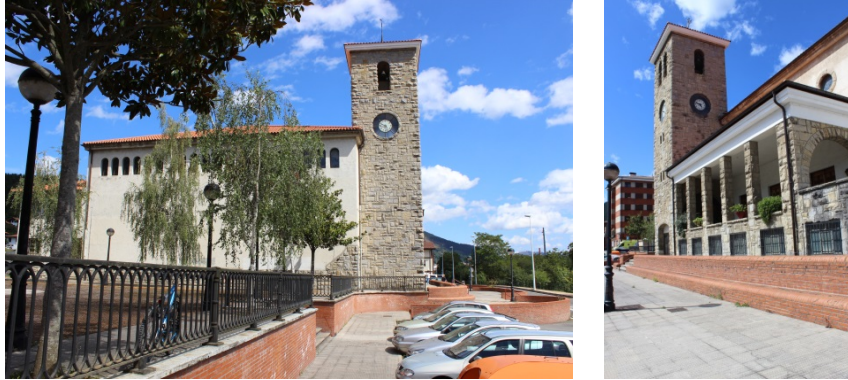
Exterior de la parroquia de la Santa Cruz de Gardea. Fotografías de la autora.
