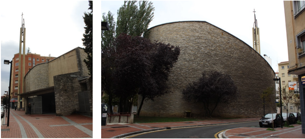
Imágenes del estado actual de la iglesia de Fisac.
