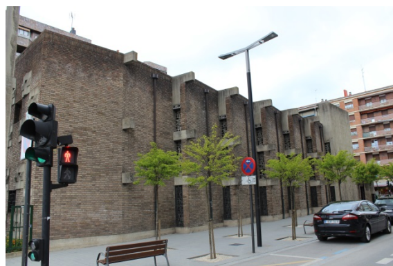
Fachada lateral en la que se sitúan los quiebrros de las vidrieras verticales. Fotografía de la autora.
