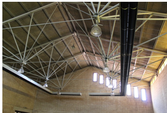
El techo de la nave deja visto el sistema constructivo, más allá de la composición tubular. Fotografía de la autora.
