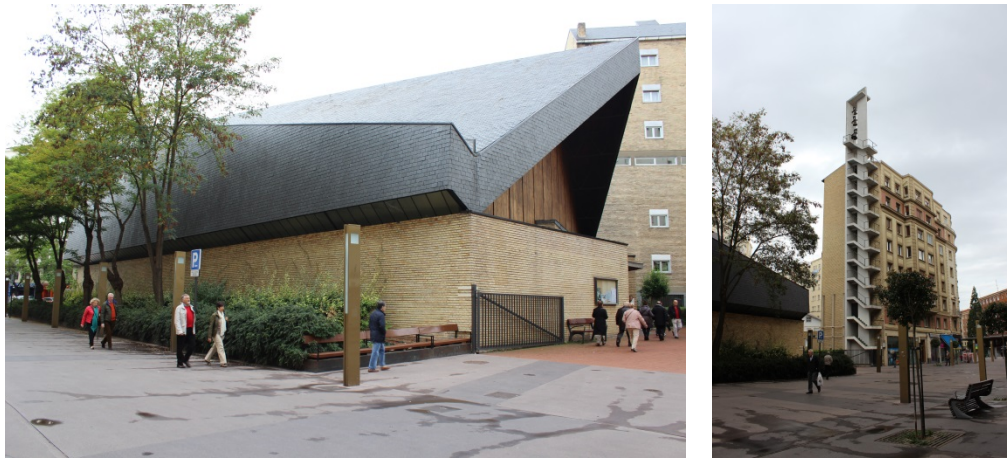
Imágenes exteriores de la iglesia en la actualidad. Vista desde la calle peatonal secundaria, hacia la fachada de acceso (izda.) y campanil adosado al edificio de viviendas de ladrillo (dcha.).
