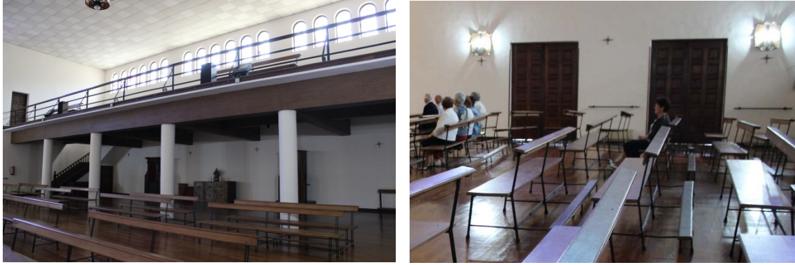
Coro alto sujeto por pilares (izda.) y bancos sufriendo las irregularidades del suelo (dcha.).
