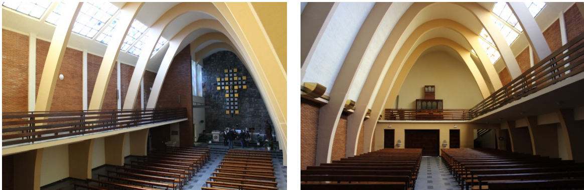
Imágenes interiores de la iglesia en la actualidad.
