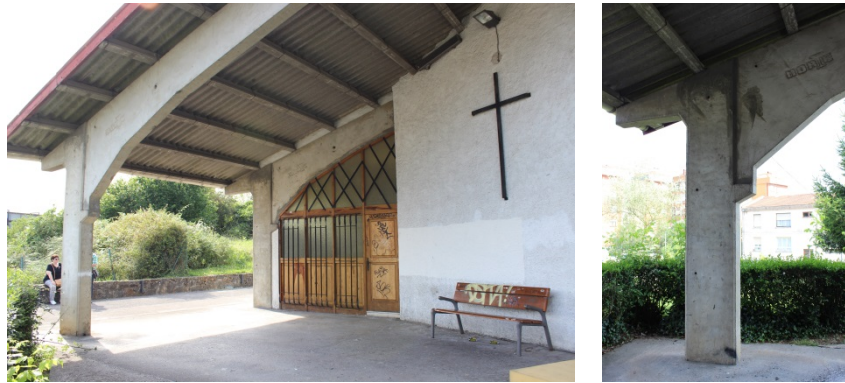
En el porche se muestra sin ningún recubrimiento el sistema constructivo de la iglesia. Fotografías de la autora.
