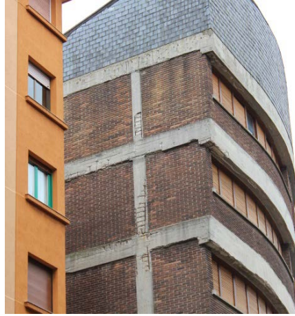
Una de las carbonataciones de la iglesia de Iztietia. Fotografía de la autora.
