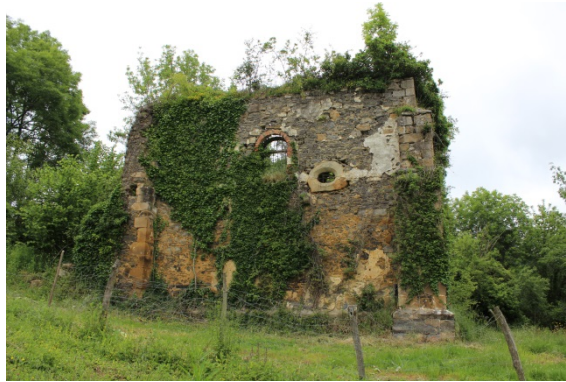
Estado actual de la antigua ermita de San Cosme y San Damián, de difícil acceso y alejada del conjunto residencial. Fotografía de la autora.
