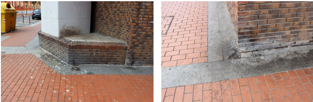
Excrementos de palomas y restos de vómito que ensucian y corroen los materiales.
