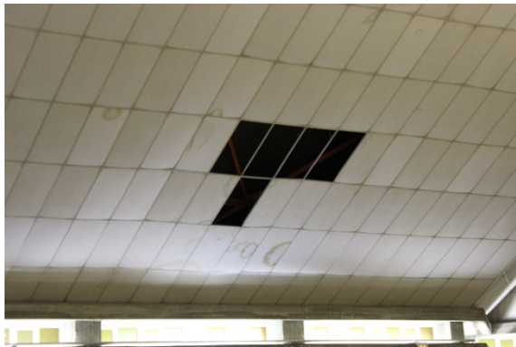
Manchas de humedad y ausencia de piezas del falso techo (izda.); problemas de humedad en cubierta (dcha.)
