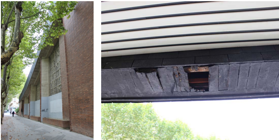
Vista de una fachada lateral, en la que se ha pintado el hormigón para tapar unos grafitis (izqda.).
