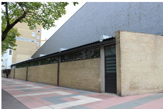
Lesiones exteriores: manchas de humedad en cerramientos de ladrillo y óxido en las sujeciones metálicas de las piezas de pizarra de la cubierta. En la planta baja del centro parroquial se han realizado pintadas.
