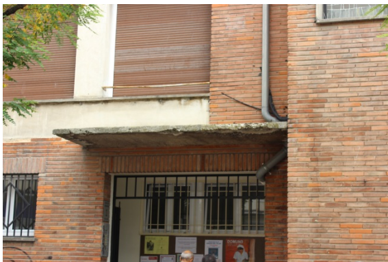
Porche de hormigón con carbonataciones (izda.) y muros de fábrica en los que han aparecido zonas oscuras debido a la humedad, grafitis y desprendimiento de ladrillos (dcha.).
