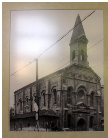
Exterior de la primera iglesia de San Agustín. Imagen situada en la iglesia.
