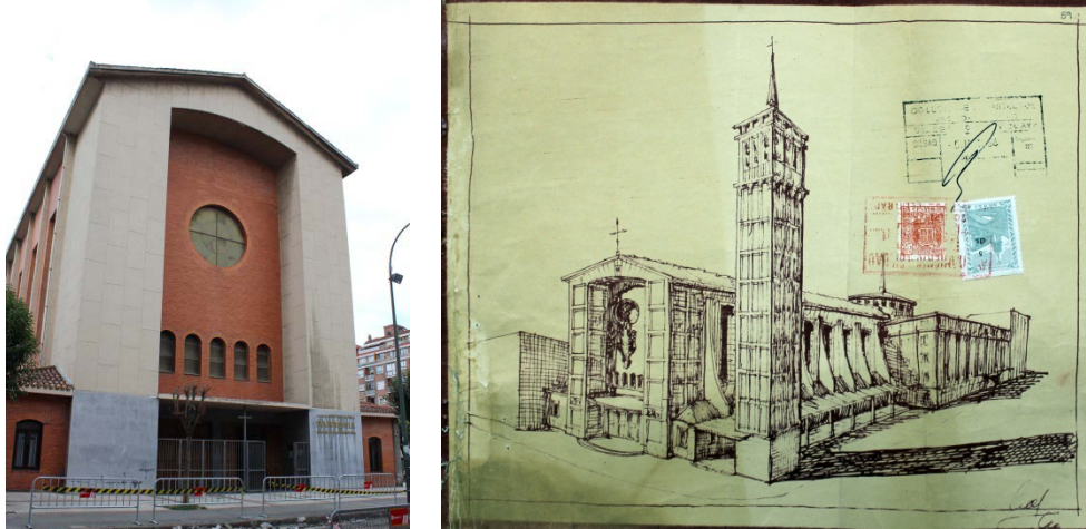
Imagen del estado actual de la fachada principal e infografía del conjunto, del proyecto original, de A. de Gortázar.
