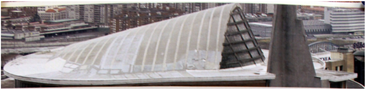
Estructura de la cubierta durante las obras.
