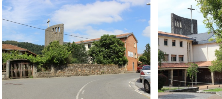
Prolongación del muro de piedra de la cabecera de la iglesia. Fotografías de la autora.
