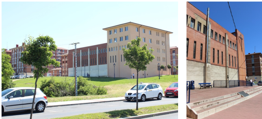
El edificio de la iglesia y sus dependencias se diferencia en volumen y aspecto del edificio de educación que tiene adosado.
