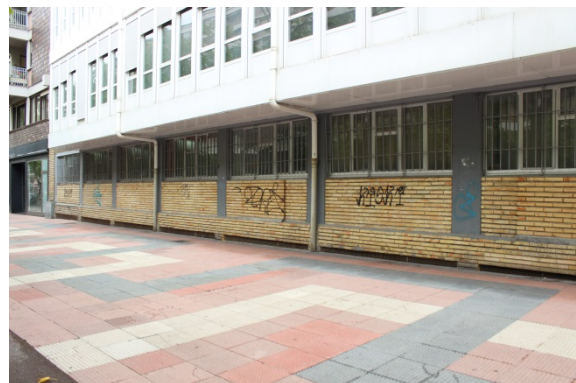
Lesiones exteriores: manchas de humedad en cerramientos de ladrillo y óxido en las sujeciones metálicas de las piezas de pizarra de la cubierta. En la planta baja del centro parroquial se han realizado pintadas.
