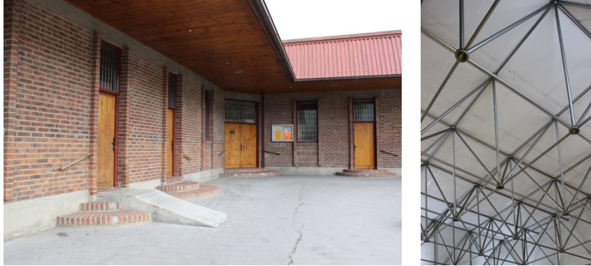
La cubierta vista desde el exterior y del interior. Fotografías de la autora.
