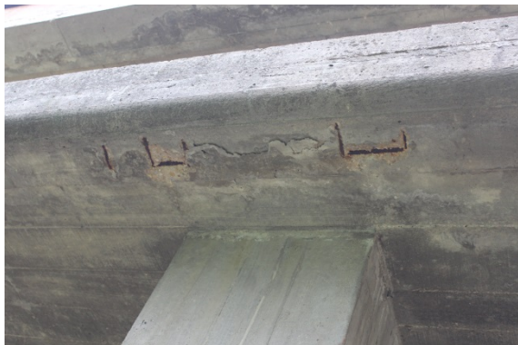
Lesiones en las piezas de hormigón: carbonataciones y colonias de microorganismos.
