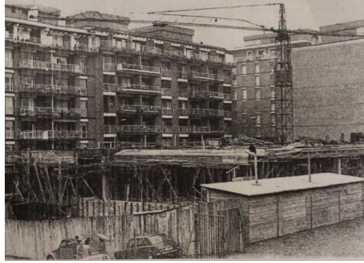
Fotografía de la construcción de la parroquia.
