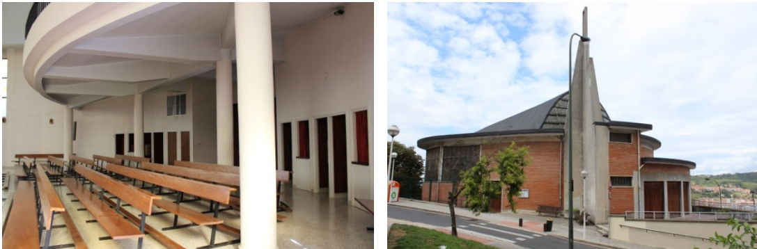
Estructura del coro (izda.); los materiales de cerramiento del edificio son ladrillo caravista, hormigón y tela asfáltica.
