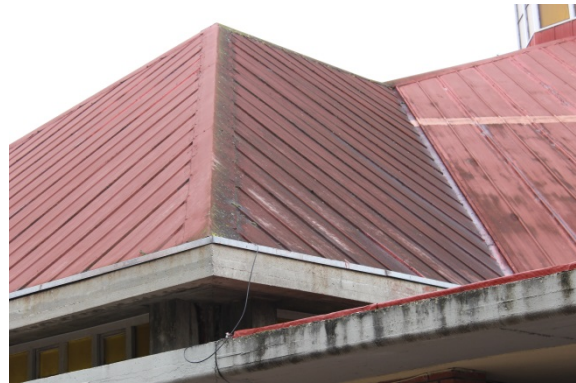
Manchas de humedad y ausencia de piezas del falso techo (izda.); problemas de humedad en cubierta (dcha.)
