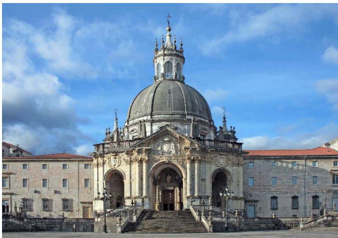
Fig. 24. Azpeitia. Antiguo colegio de San Ignacio de Loyola. Basílica. Fachada.
