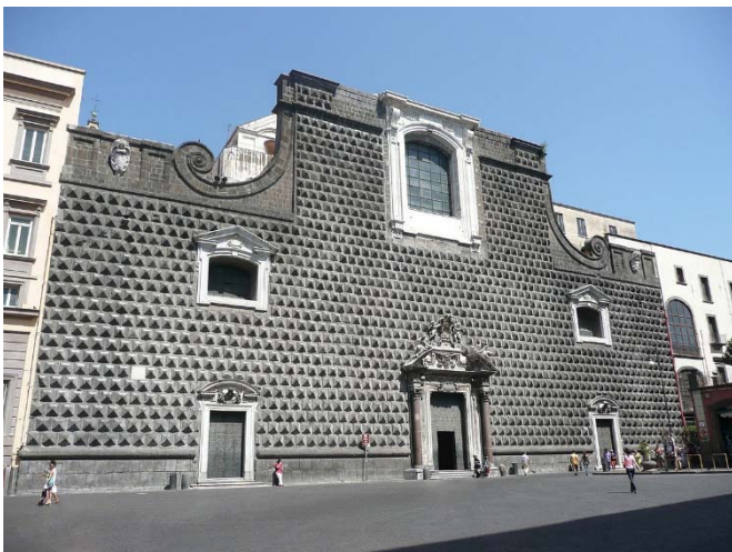
Fig. 7. Nápoles. Iglesia de Gesù Nuovo. Fachada.
