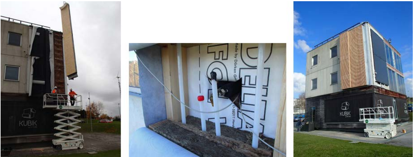
Fig.5. Demostrador en el edificio Kubik donde se aprecia el montaje de los paneles, el ensamblado de instalaciones y el acabado final tras la instalación de los módulos.
