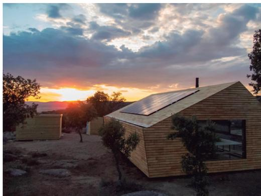
**Fig. 6.** (Derecha) Alero sur inclinado para recibir la mayor radiación solar posible.
