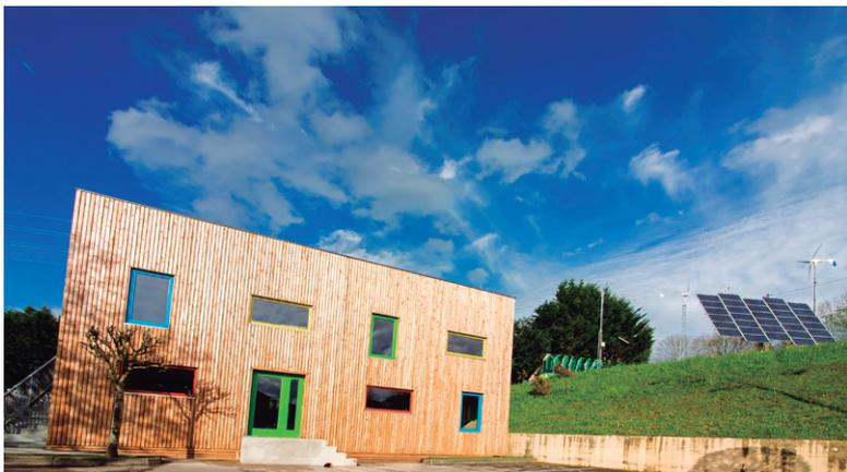
**Fig. 6.** Módulo prefabricado altamente eficiente hecho con madera local. Usurbilgo Lanbide Eskola, 2016.
