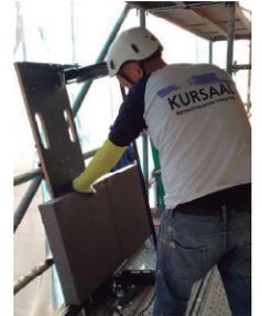
Ejecución de molduras con aislamiento térmico y máquina de corte específica.
