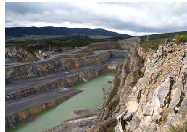
Fotografía 20: Las canteras de Iruña de Oka, junto con el Parque Eólico de la Sierra de Badaia, constituyen una de agresiones paisajísticas más relevantes de la unidad.
