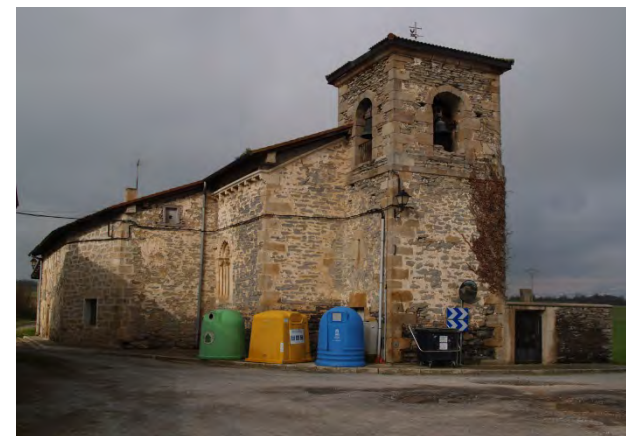
Fotografía 15: Iglesia de San Vicente Mártir en Miñano Gutxia constituye un modesto pero atractivo ejemplo de arquitectura románica del siglo XIII. Aunque reciclar es muy loable, salta a la vista que los contenedores podrían haberse situado en alguna otra parte.
