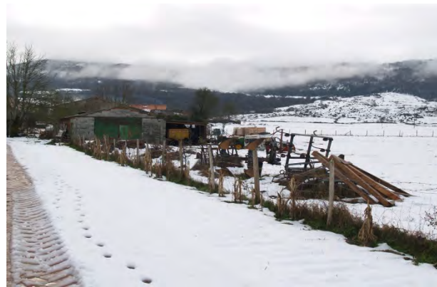
Fotografía 20: En las inmediaciones de Arrizala, al igual que en otros núcleos rurales, se producen impactos relacionados con el abandono de antiguas naveas agrícolas, maquinaria vetusta, aperos y otro tipo de residuos.
