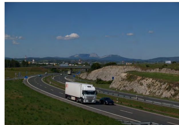
Fotografía 19: El trazado de la Nacional 1, al igual que otras infraestructuras lineales o puntuales, al tiempo que rompe la imprescindible conectividad paisajística y ecológica, genera evidentes e insalvables impactos.
