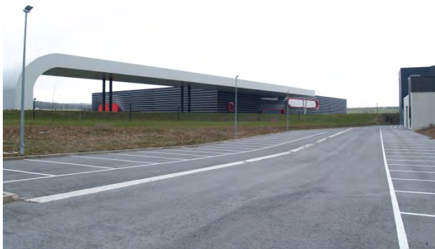
Fotografía 10: El Parque Tecnológico de Miñano constituye uno de los hitos emblemáticos de la unidad. Sus edificios e instalaciones representan toda una singularidad en el paisaje de La Llanada.
