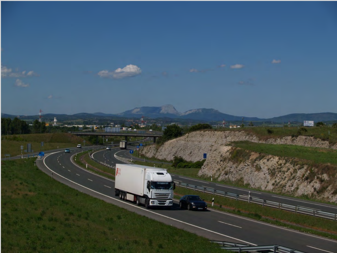
Fotografía 12. Las vías de comunicación importantes se configuran como uno de los elementos más interesantes a la hora de determinar el potencial de vistas de un paisaje.
