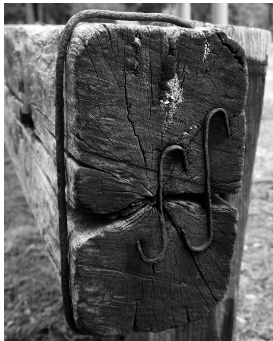
Figura 12. Sistema para prevenir el agrietamiento transversal debido a la liberación de tensiones de crecimiento, mediante el uso de grapas metálicas. Foto: G. Vargas.
