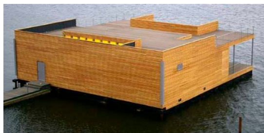
Figura 14: Vivienda ecológica fabricada con biocompuestos (21)
