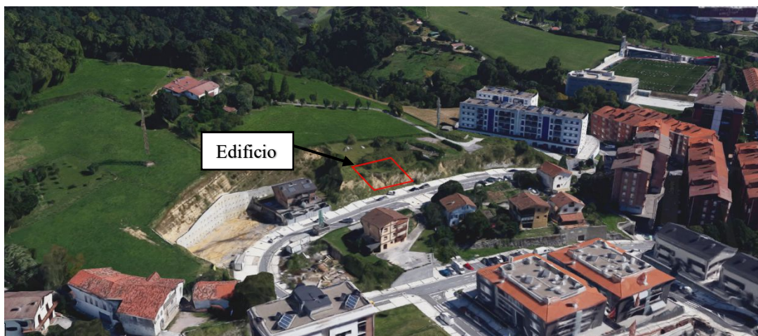
Imagen 1.2: Emplazamiento del edificio
