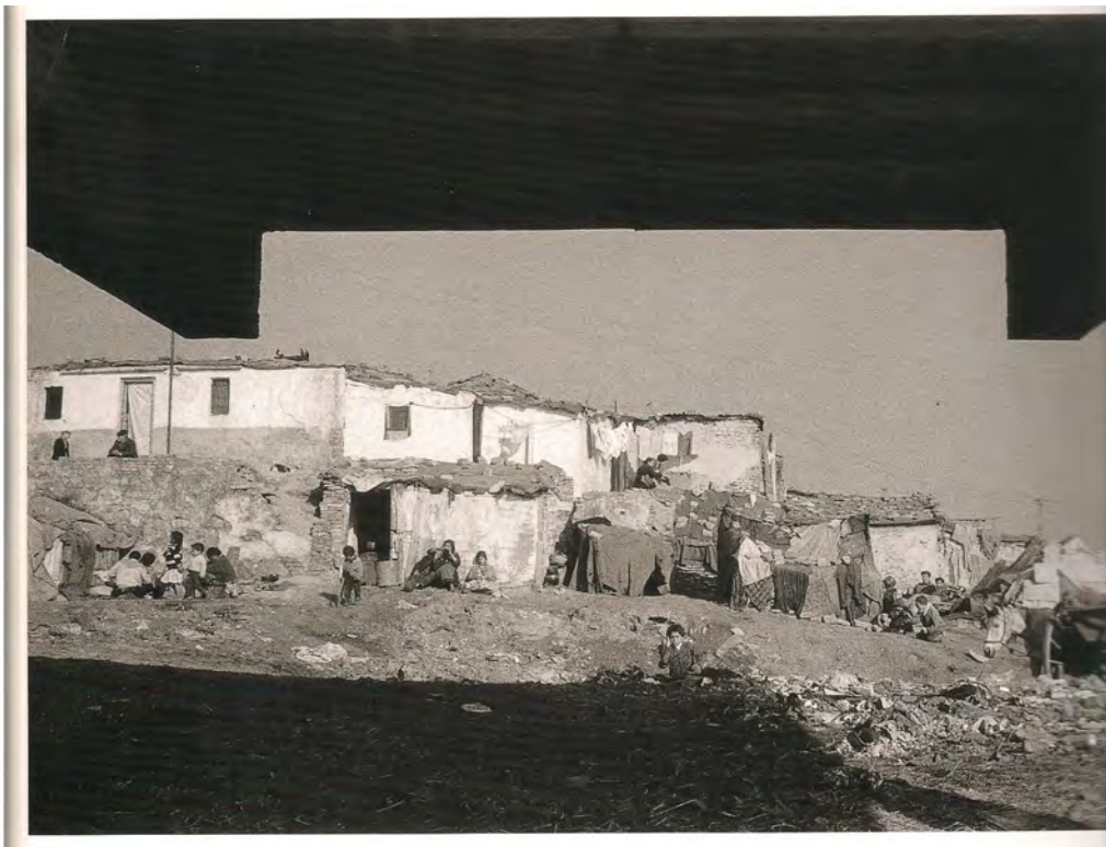
El barrio de chabolas en la playa del Somorrostro (Barcelona, 1964). El avances de la construcción de la carretera amenaza al barrio poco antes de su demolición 197 .
